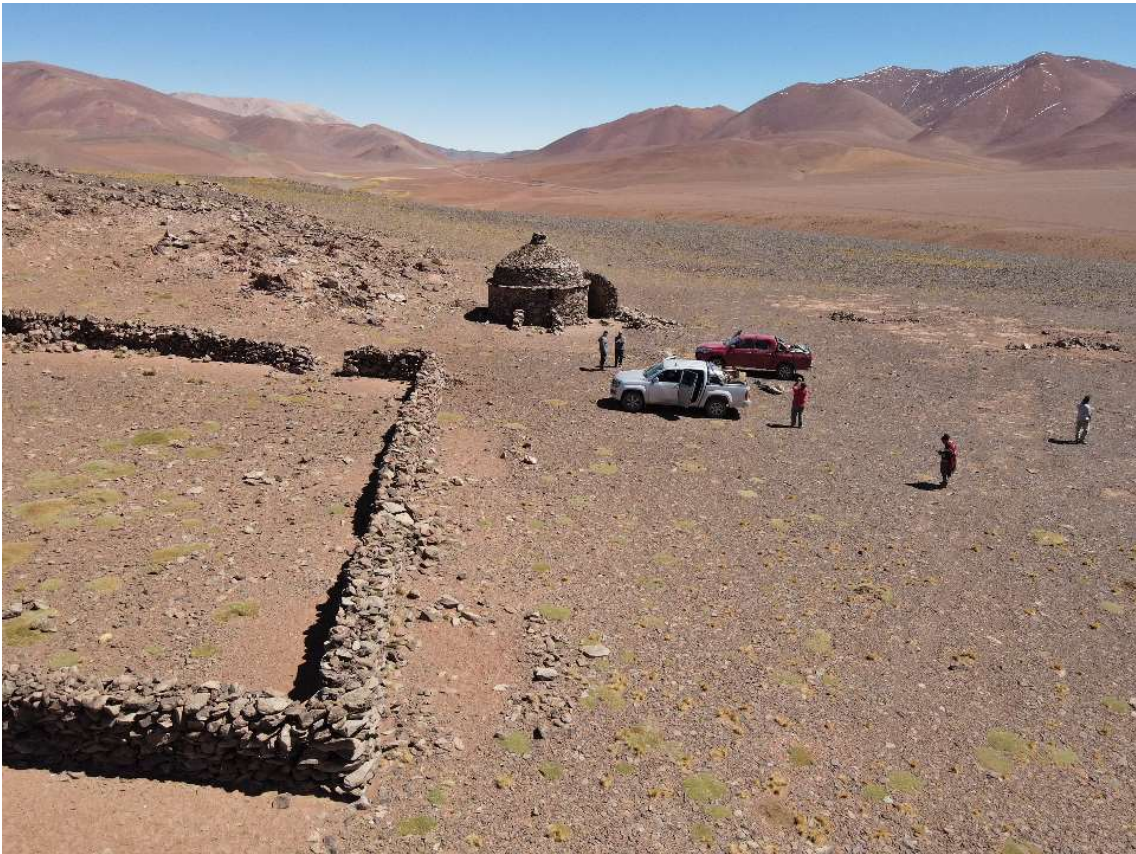
Ilustración 75 Refugio El Zanjón. Departamento Vinchina 4X4
