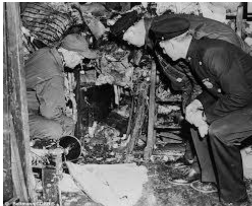
Túnel a través de basura acumulada, a través del cual Langley accedía a la casa
