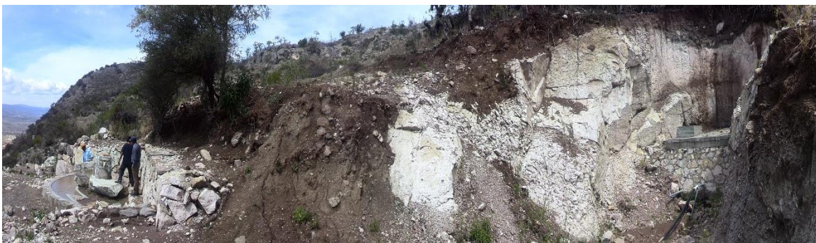
Obras de captacion de agua cerro del capulin
