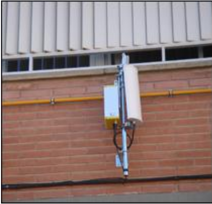
Puntos de acceso instalados
