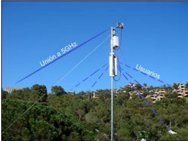
Detalle de antena instalada
