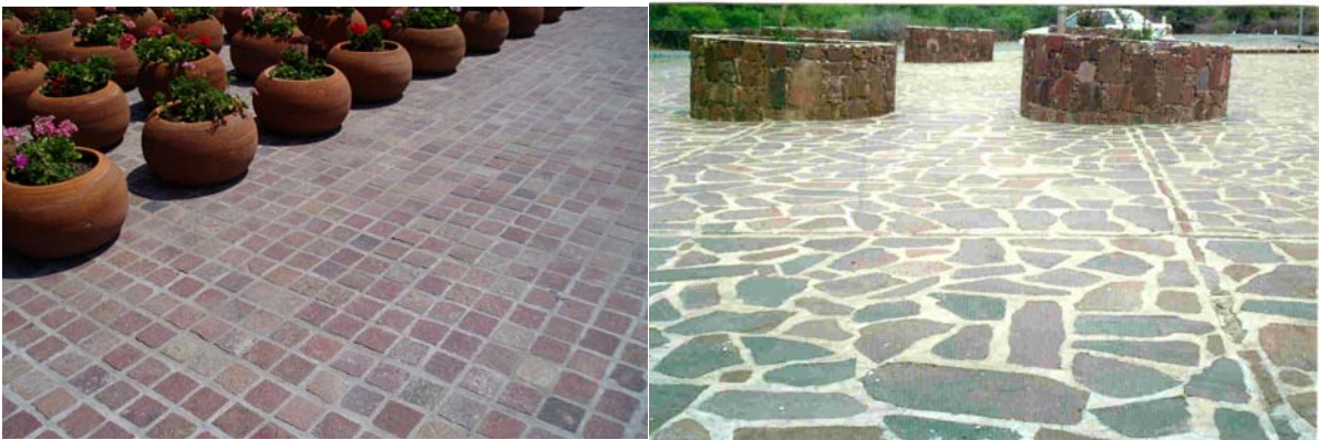
Fotografía 17. Usos del pórfido riolítico en pisos, el lado izquierdo en forma de cubos y el lado derecho en forma de polígono irregular.
