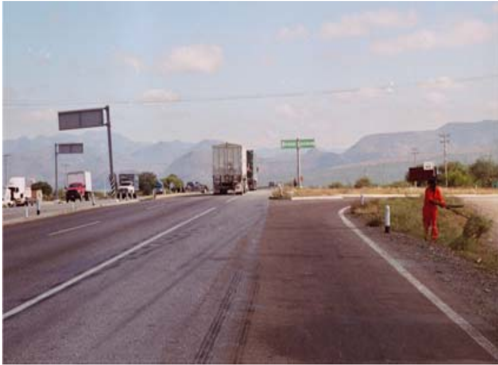
Fotografía 3. Autopista federal No. 57, Querétaro-San Luis Potosí, principal vía de comunicación a Tierra Nueva.
