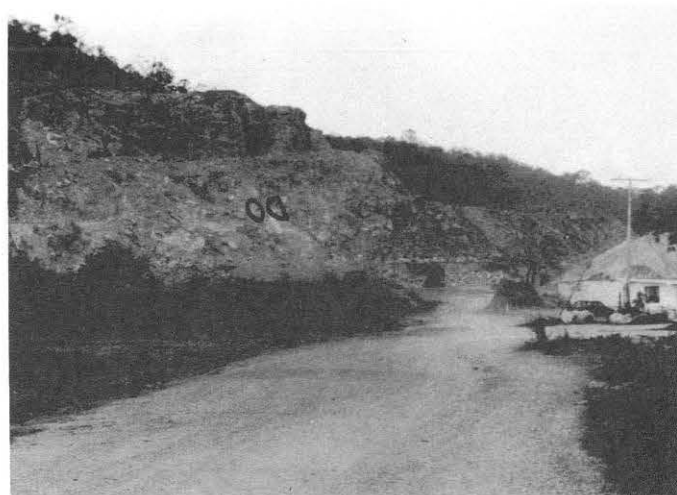
Fig. 25. Depósitos de dolomita de alta calidad bajo intensa explotación a cielo abierto, La Concepción, Estado Yaracuy. Los depósitos caracterizan enormes masas lenticulares de mármoles dolomíticos con alto contenido de MgO en contacto con calizas grises. La zona fue investigada por el Ministerio de Energía y Minas, durante 1985 y evaluada en detalle por el sector privado de acuerdo a parámetros genéticos muy bien establecidos.
