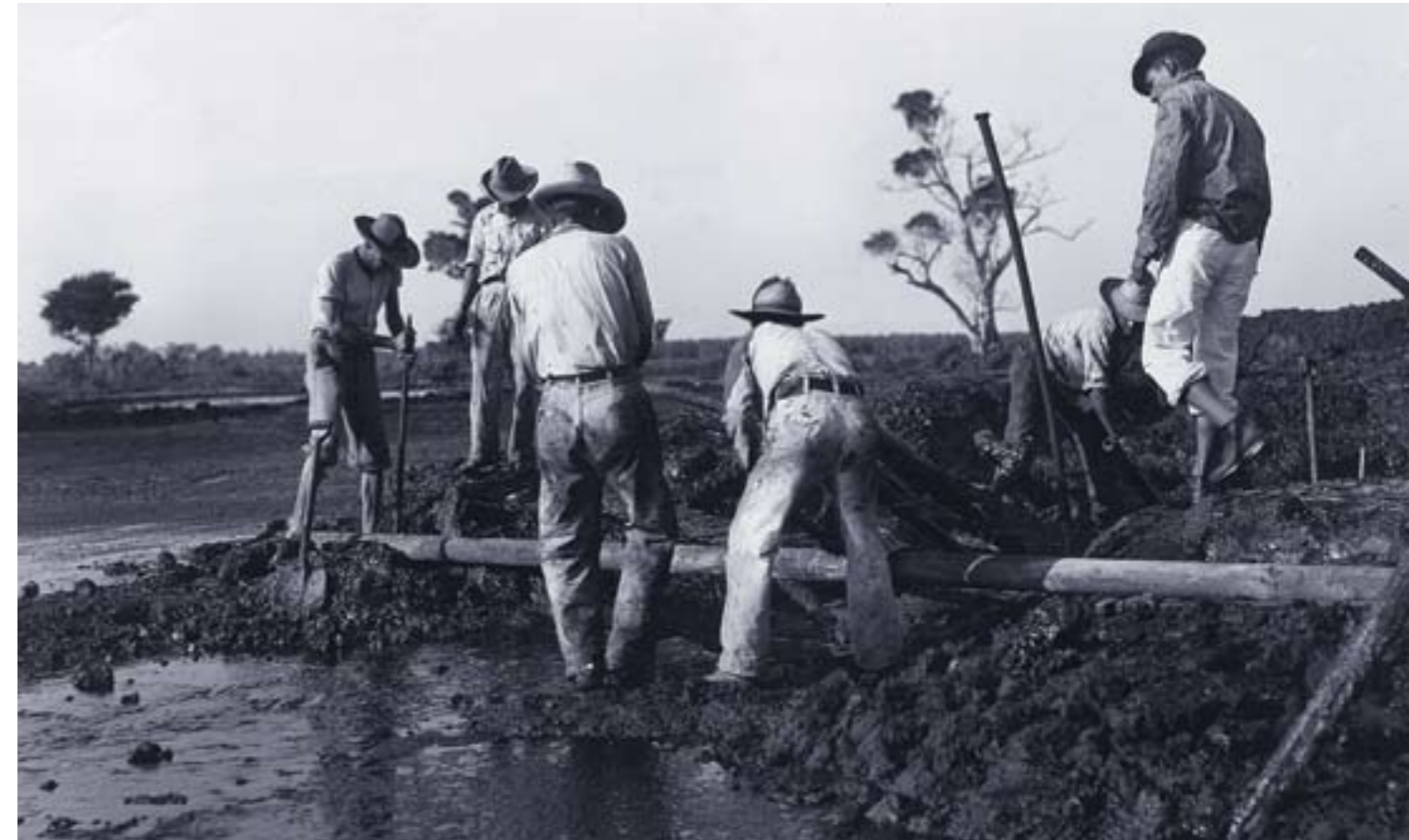
Instalación de oleoductos, ca. 1940, AHP.
