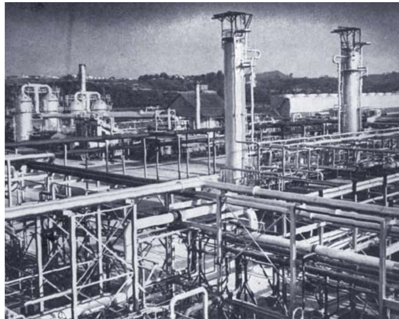
Vista parcial de las instalaciones en la refinería de Poza Rica, ca. 1950, Biblioteca Antonio J. Bermúdez, Pemex.
