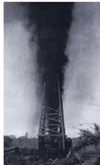
Pozo Cerro Azul Núm. 4 en plena actividad, 1916, AHP.
