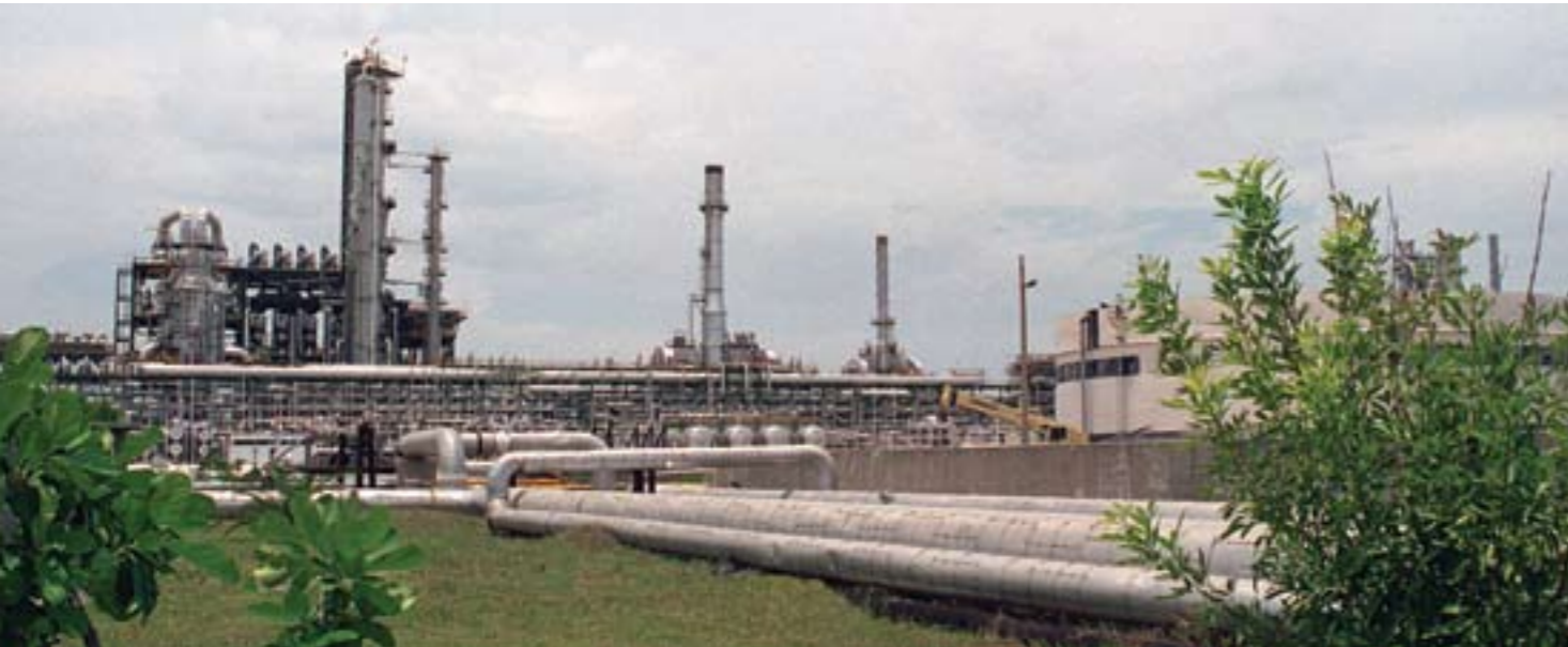
Vista parcial de la planta refinadora de Ciudad Madero, Gerencia de Comunicación Social, Pemex.
