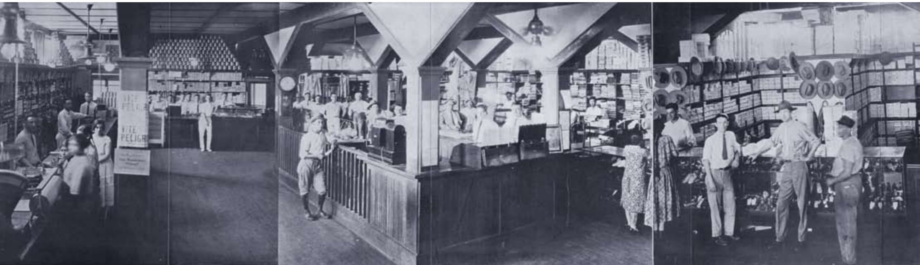
Vista interior de la tienda que daba servicio a obreros y empleados de la Huasteca Petroleum Company en la terminal y refinería de Mata Redonda, Tampico, 1926, AHP.
