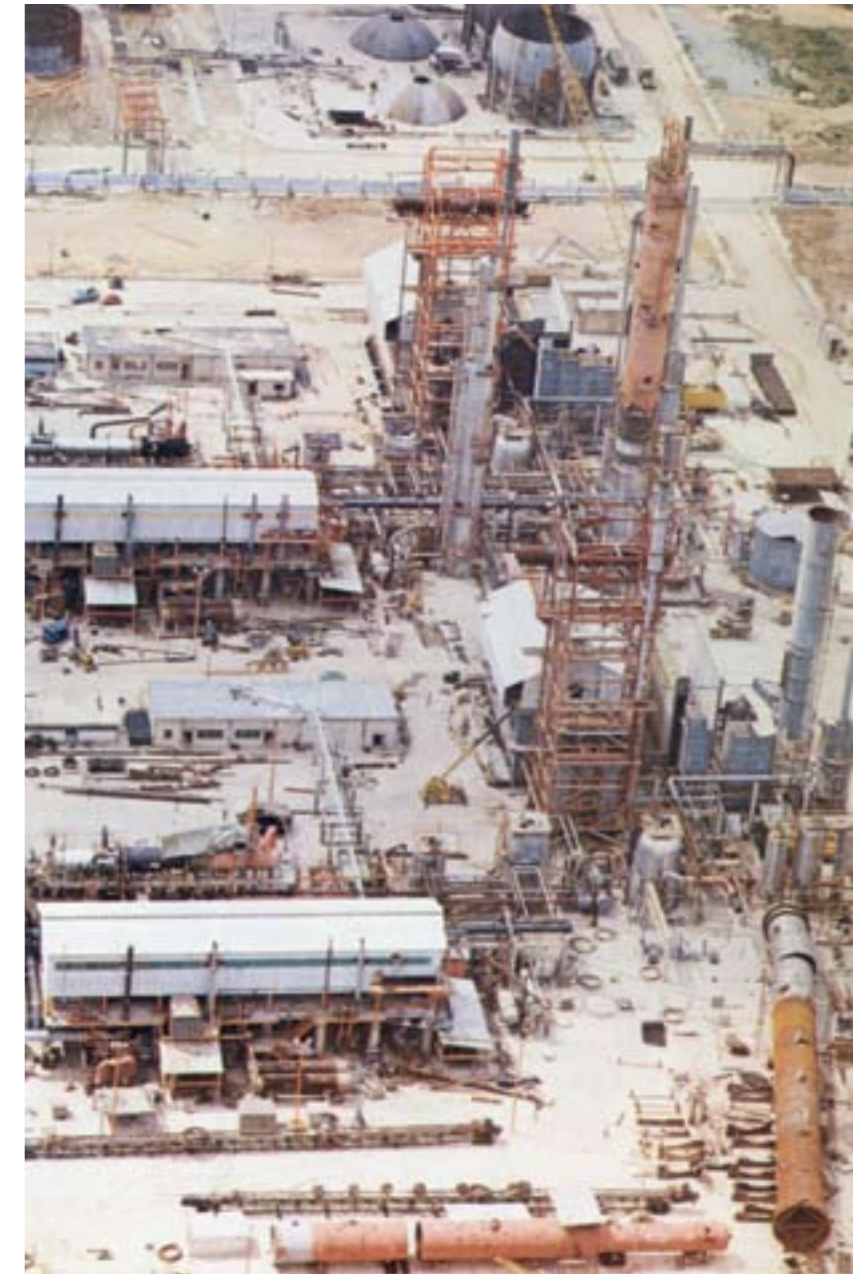
Construcción de la planta de Cosoleacaque, 1976, Biblioteca Antonio J. Bermúdez, Pemex.
