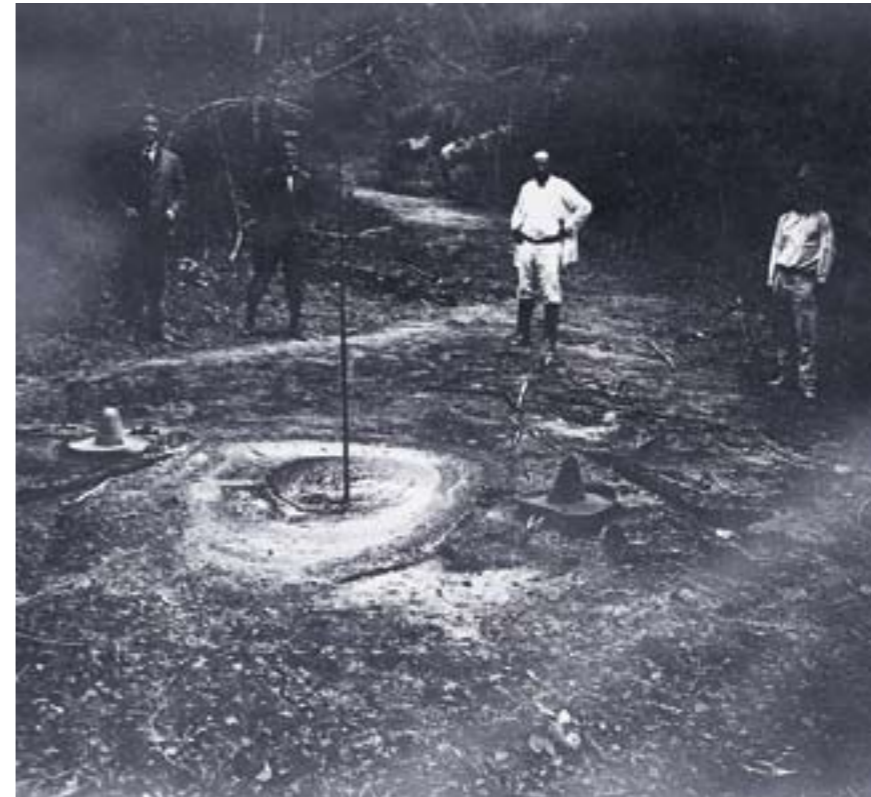
La explotación de un yacimiento comenzaba por la localización de chapopoterías. Una de ellas situada probablemente en la Faja de Oro. Véanse los sombreros de paja sobre el petróleo, ca. 1920, AHP.
