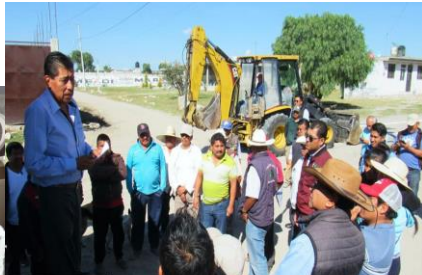
U XCOLOTLA AYUNTAMIENTO 2018-2021 INICIO DE OBRA "LINEA DE AGUA POTABLE"
