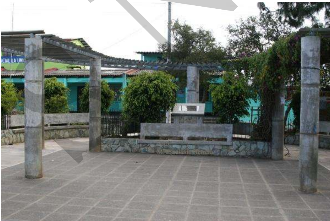
Pérgolas del Parque Central de San Pedro Jocopilas
