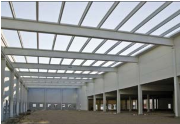
DETALLE - VIGA PREFABRICADA
