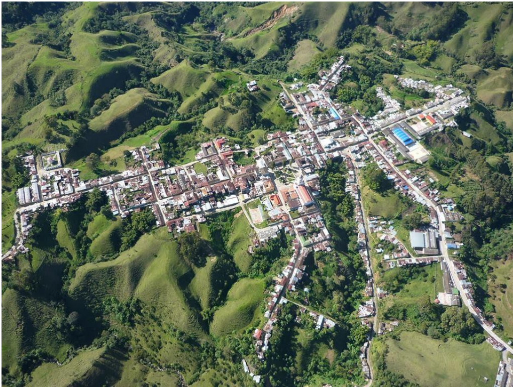
Figura 7. Vista aérea del Municipio
