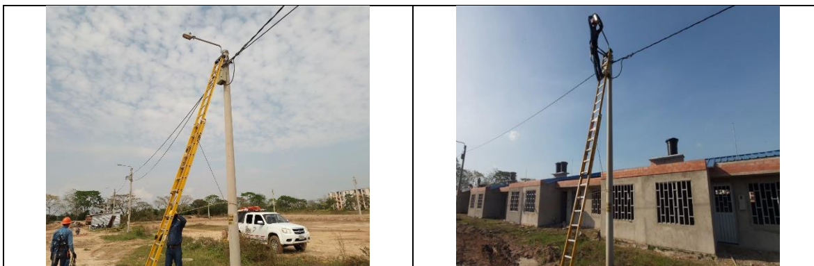
Fotos 2: Fotos de trabajos de modernización del SALP
