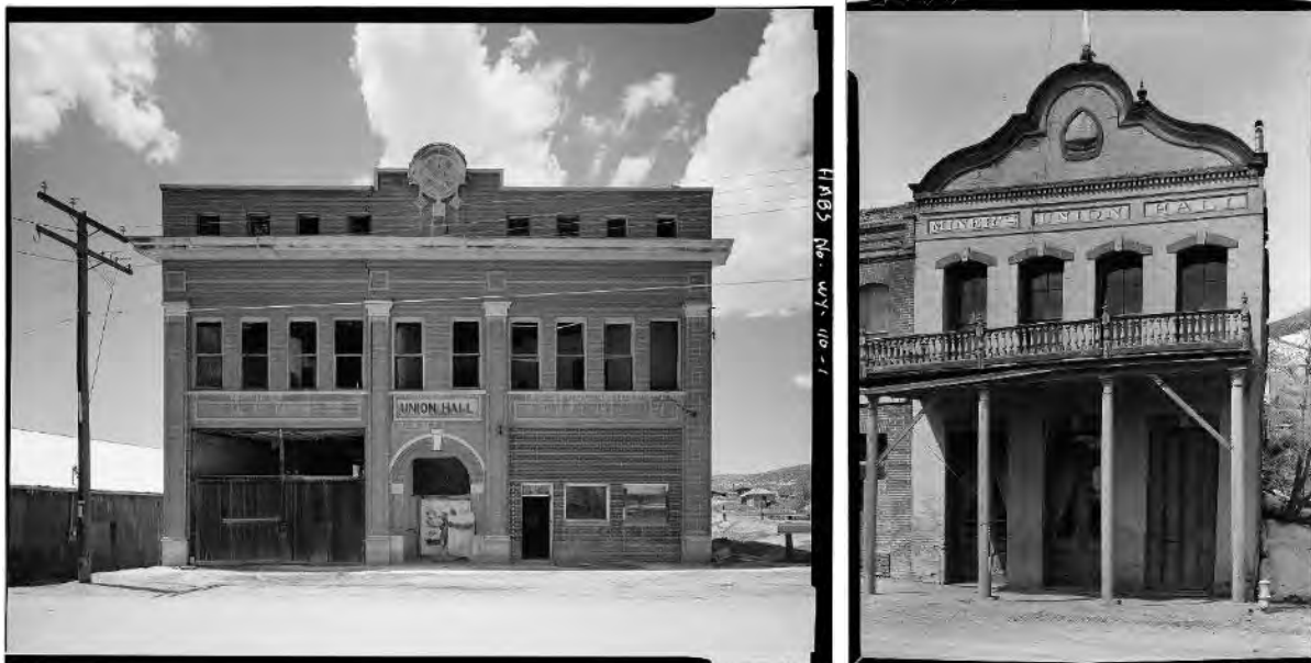
(L) Union Hall, Superior, WY, 1991 (Val Brinkerhoff, LOC P&P, HABS WY-110)
