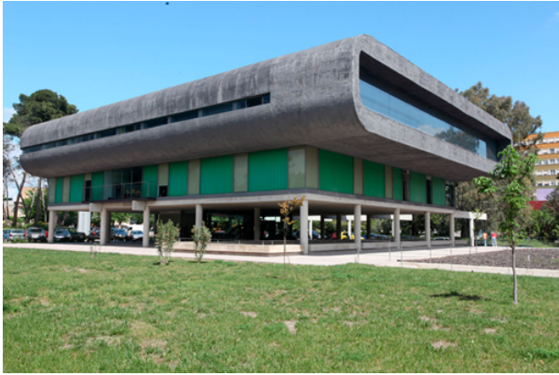
Figura 6. Edificio de Salud Responde.
