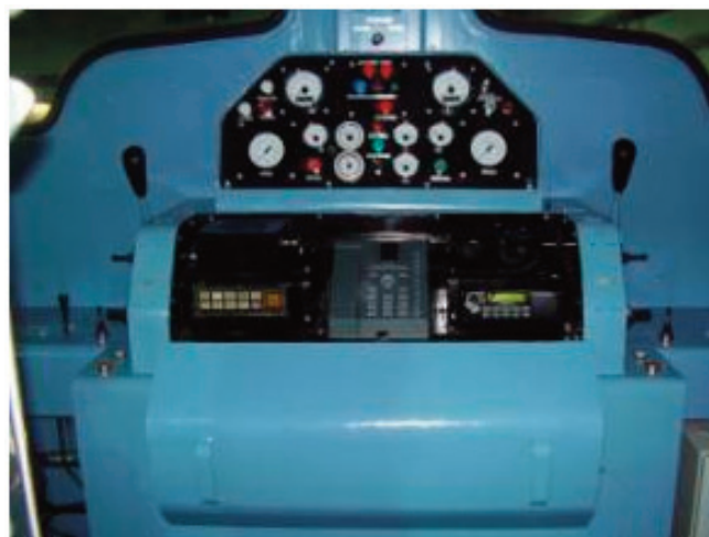
Fig. 9. Detalle de la cabina pintada con todos los mandos instalados
