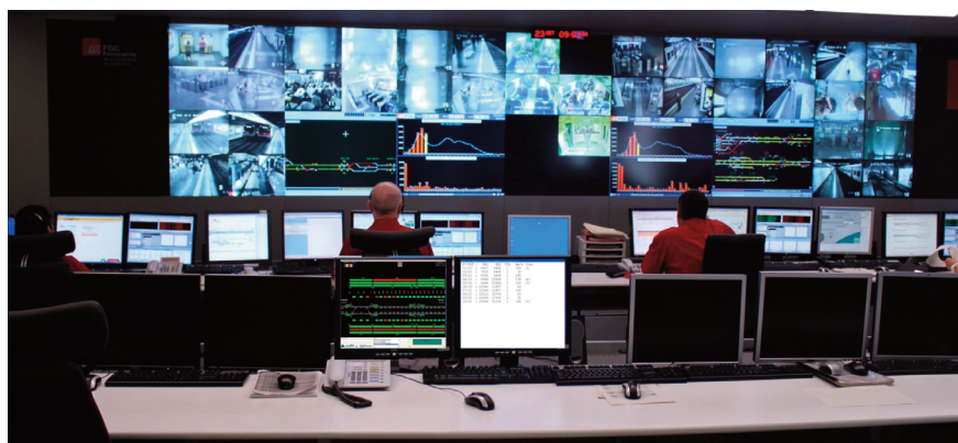
Fig. 6. Simulación del Puesto de Mando Central de ERTMS (PCE) en el CCI de FGC
