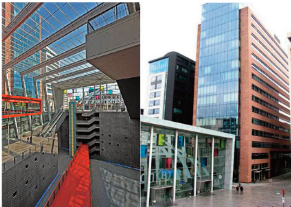
Fig. 2. (a) Nuevo vestíbulo sur de la estación y desarrollos urbanos anejos (b) Edificios de oficinas y hoteles junto al acceso sur de la estación.
