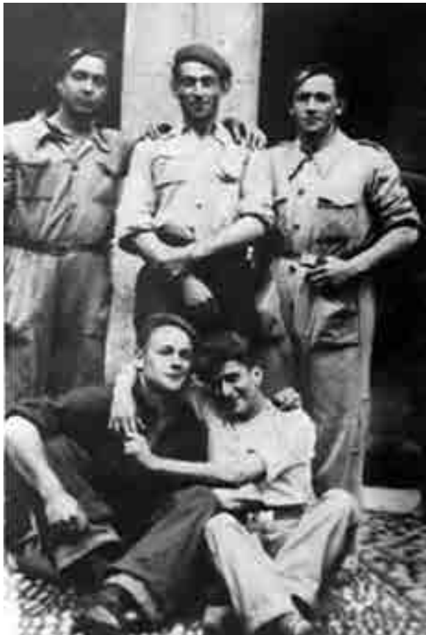
14. Po. Tras la derrota algunos gudaris fueron llevados a la base de Zorroza en Bilbao, al Servicio de Recuperación de Automóviles, dentro de los batallones de trabajadores. Uno de ellos fue Juan Urrutia, cuyo antiguo oficio de carrocerero en Mariano Corral le permitió acceder a este campo de trabajo. De izquierda a derecha y de pie: Julián Jáuregui, Juan Urrutia, Félix Urrutia. Agachados: Sin identificar y Valeriano Eguia. Año 1938.
