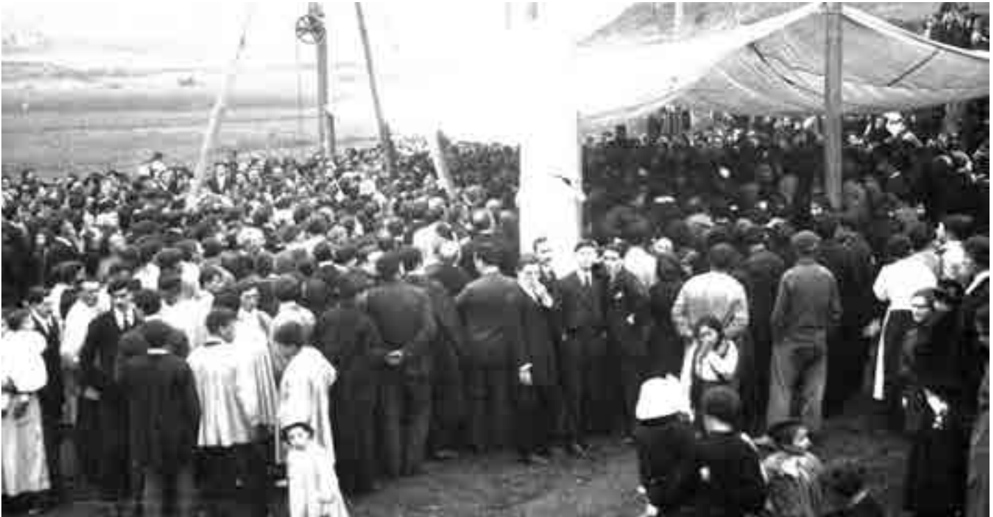
16. Urb. El 25 de febrero de 1917 tuvo lugar la colocación de la primera piedra del reformatorio de Amurrio. Al acto acudieron el obispo de la diócesis y los gobernadores de Álava y Vizcaya. Fue el primero que se construyó en la península. La labor y el patrocinio de Gabriel María de Ibarra, presidente del tribunal de menores de Bilbao, fue esencial para su construcción.
