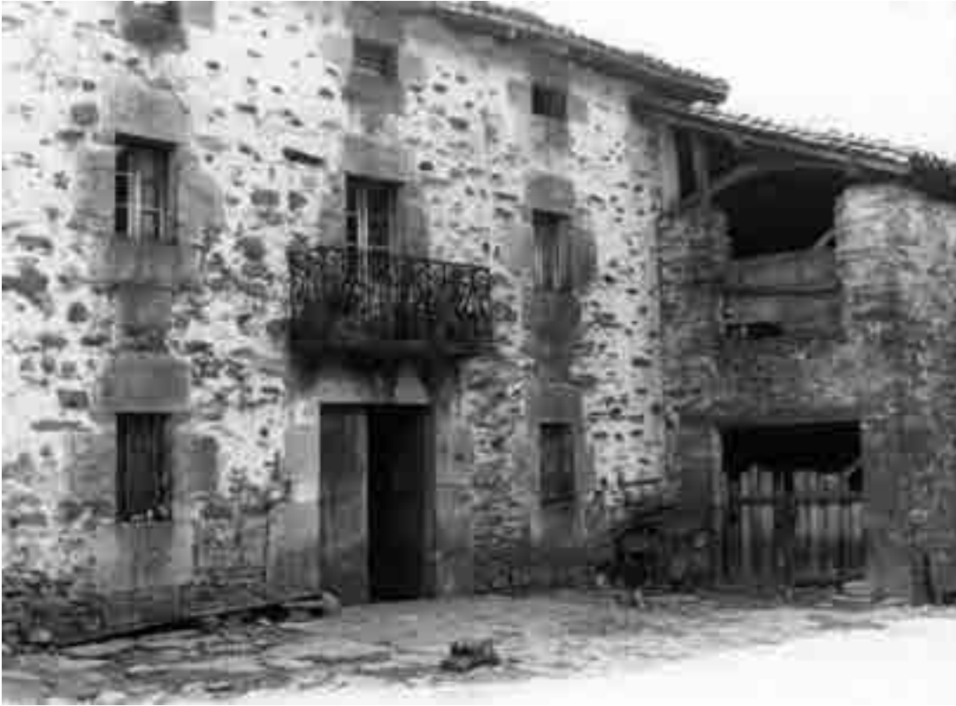
38. Urb. Aldama. Un incendio arrasó, hace años, la casa solar del conde de Aldama. En las rejas del balcón estaban forjadas las iniciales de su hidalguía. Dicha casa se la conoce como caserío Olarieta.
