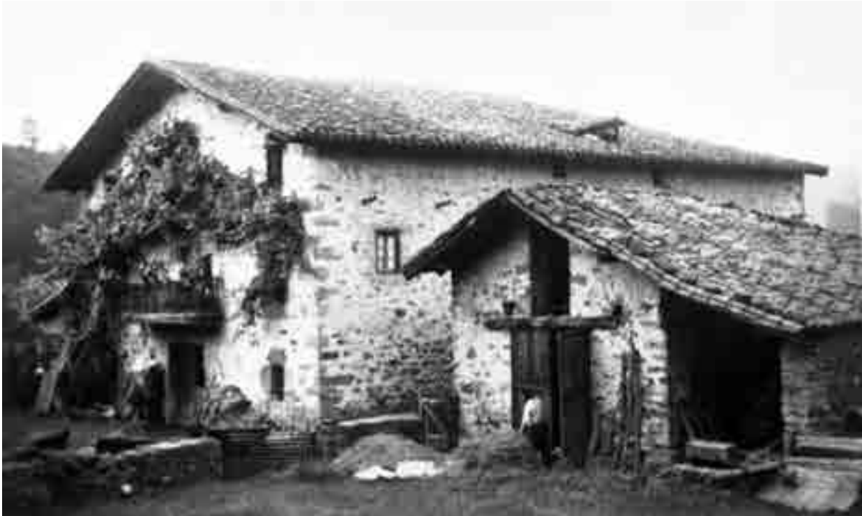
43. Urb. Caserío San Pablo. Un ejemplo más de la larga lista de edificios desaparecidos en el municipio en el transcurso del siglo pasado. La instalación de la empresa Tubos Reunidos lo hizo desaparecer. Debe su nombre a la ermita de San Pablo de Urieta situada en sus cercanías.
