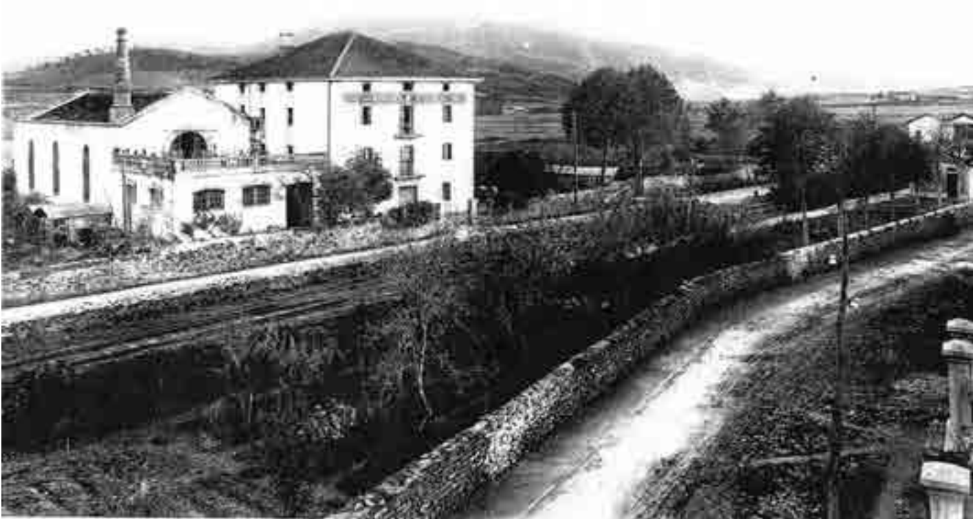
33. Urb. La destilería Manuel Acha, el ferrocarril de vía única y la calle de la estación. Esta última era una de las pocas calles asfaltadas con “escarabilla” proveniente de la combustión del carbón de los trenes. La primitiva estación, la de ahora es de 1930, estaba un poco más cerca del pueblo y era un simple edificio de planta alargada y una sola altura.
