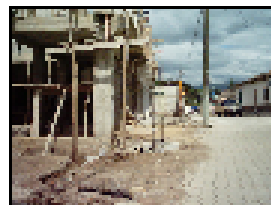
FOTO 14. DENTRO DEL CASCO URBANO DE SAN JACINTO SE ENCUENTRA UBICADO EL EDIFICIO DEL MERCADO MUNICIPAL QUE ACTUALMENTE ESTA EN CONSTRUCCION.
