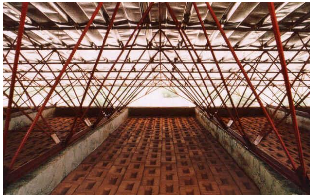
Fotografía 31 Estructura Metalica cubierta Francis Kere. Fuente:www.arquitecturaviva.com
