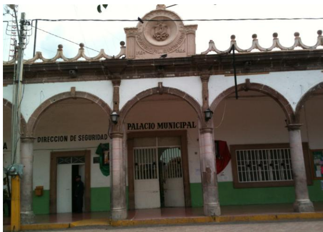
Palacio Municipal de Yurécuaro, Estado de Michoacán.
