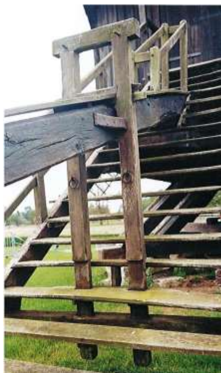
Deux détails du moulin de Saint-Maxent (Somme) : suspension de l'échelle du meunier avec la « traverse » sous les limons. Photos J.B.
