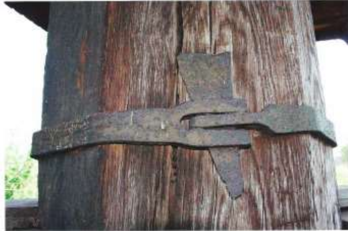
Moulin d'Argenteuil à Ohain (Brabant wallon) : Bende à moufle et clef autour du pivot au-dessus de la croisure. Photo J. Vingtcent (2008).
