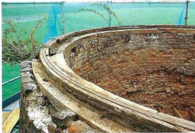
Grand et petit chemins de glissement du moulin de St-Vaast-en-Cambrésis en 1990. Photo J.B.
