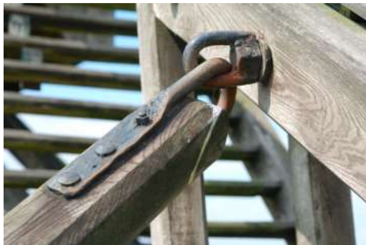
Moufle pour la suspension d'une dame au moulin sur pivot de Huise (Fl.-Or.). Photo de l'auteur.
