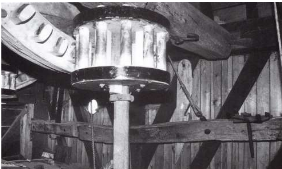
Longue bascule du frein du moulin de Huise (Fl.-Or.) Derrière la bascule on distingue le bec de cane qui soutient la bascule lorsque le frein est desserré. Photo P.B.
