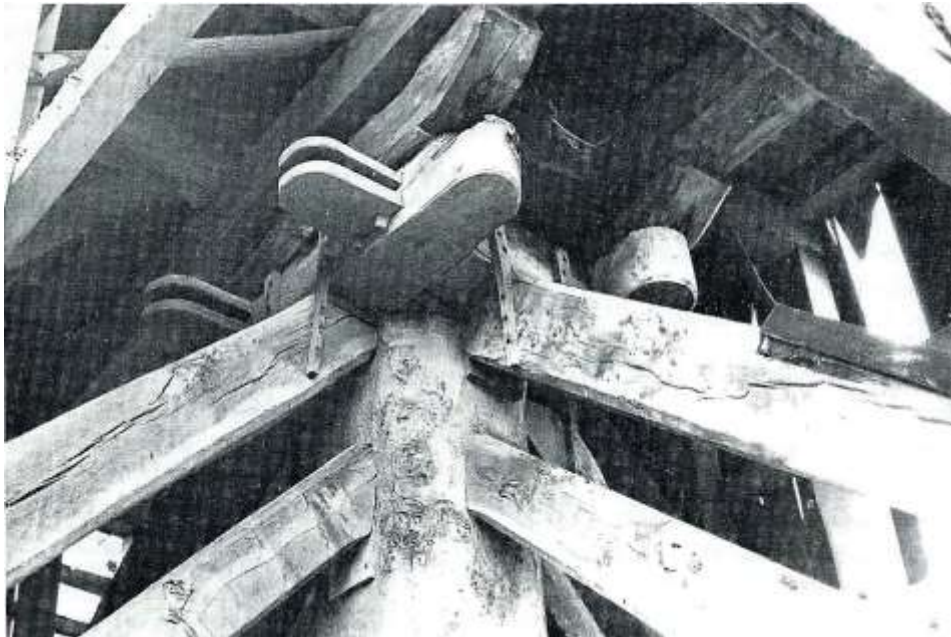
Chevaliers intercalés entre les trattes et la chaise du moulin de Leisele (Fl.-Occ.). Photo V. De Tier (WVD).
