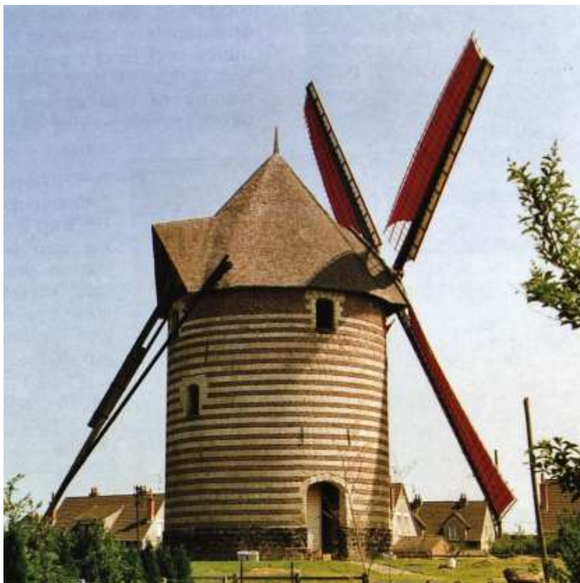
Moulin de Beuvry (Pas-de-Calais) : capitel au-dessus de la queue. Photo J.B.
