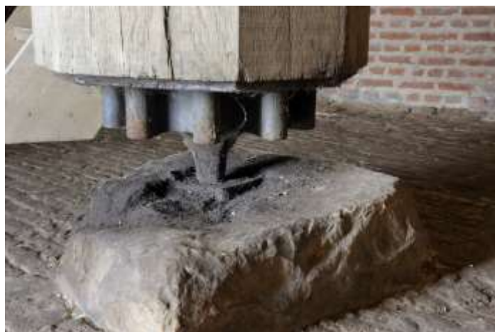
Moulin de Vertain à Templeuve : pointe de fer à l'extrémité inférieure du pivot central qui tourne sur un coussinet de fer enchâssé dans une pierre de grès. Photo de l'auteur.
