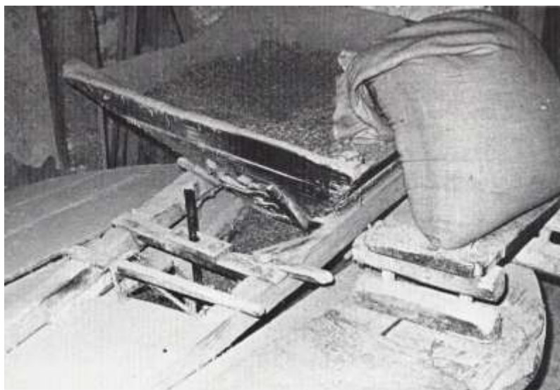
Velzeke (Fl.-Or.), Driesmolen. Devant la trémie du moulin à eau le sommet du frayon dépasse la traverse dans laquelle il tourne. Photo R. Buysse
