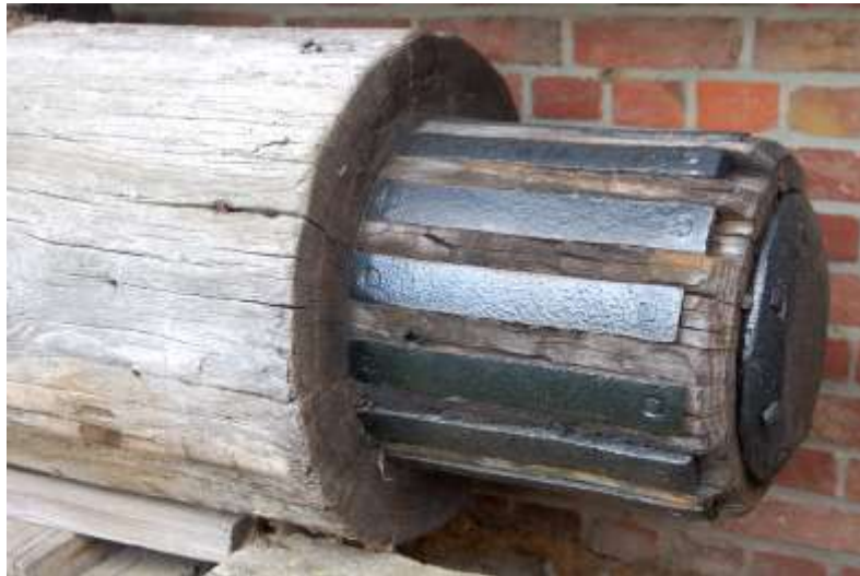
Alumelles au petit collet de l'arbre moteur du moulin à vent de Templeuve et platine servant de butoir. C.R.M. Photo de l'auteur.
