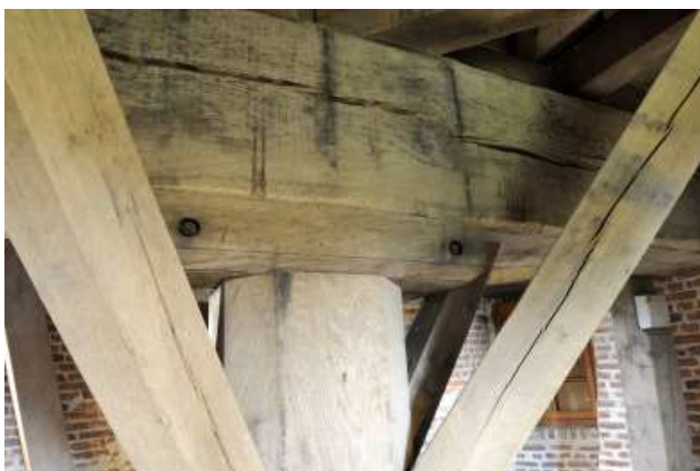
Moulin Vertain de Templeuve en Pévèle : faux ventre entre le maître-sommier et le pivot tournant. Photo de l'auteur (2016).
