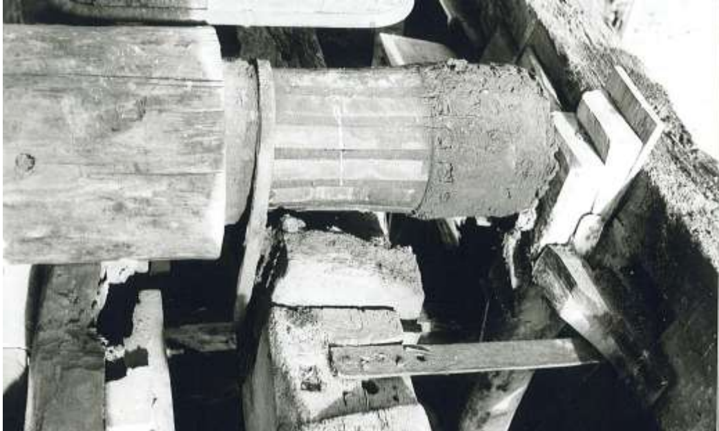
Noordmeulen (Moulin du Nord) de Steenvoorde (Nord) (1978). : petit collet de l'arbre moteur avec sa prison de fer et le butoir à droite. Photo J.B.
