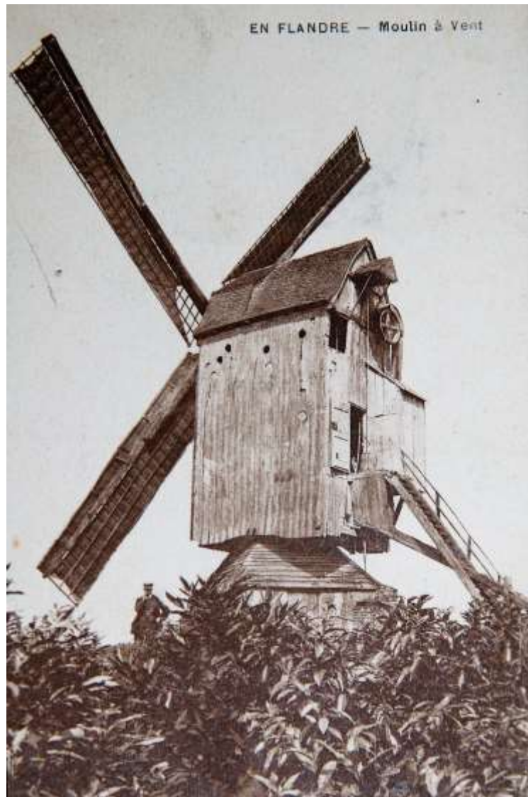
Planches reliant la queue au petit balcon pour faciliter le passage des sacs au moulin de Saint-Jans-Cappel (Nord). Première moitié du 20 e s. Collection J.B.
