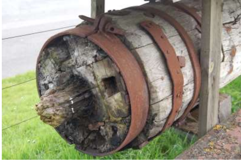
Capel, large anneau de fer, au sommet de l'ancien pivot du moulin d'Attiches (réédifié depuis à Valmy). CRM. Photo de l'auteur.
