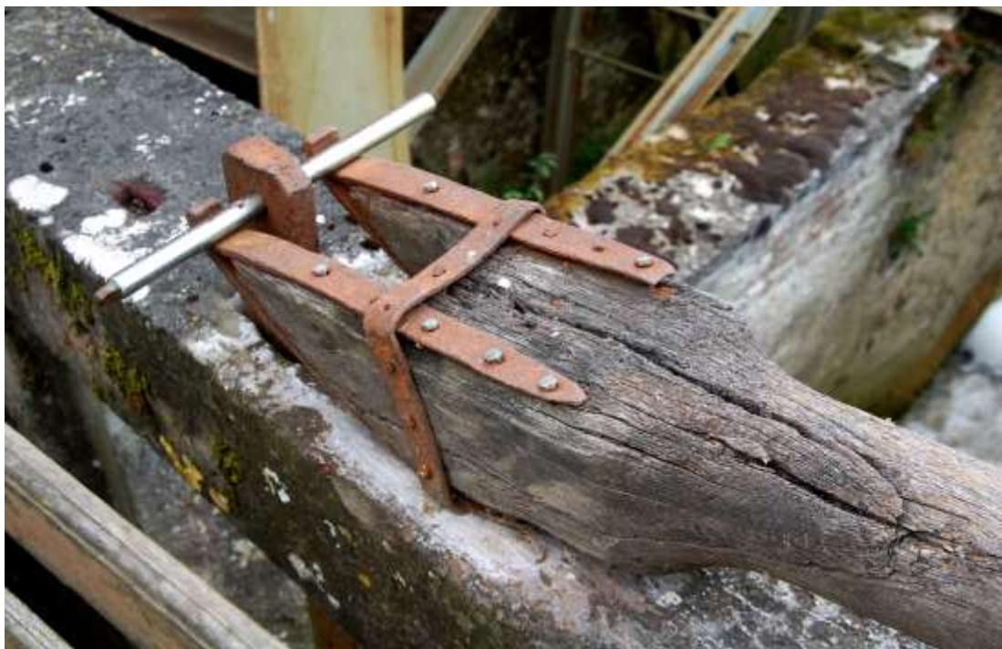
Wodecq (Hainaut) : le meunier du moulin du Tordoir manie la fourche pour soulever la vanne. Tête de la fourche avec les bandes de fer de consolidation. Photos de l'auteur.
