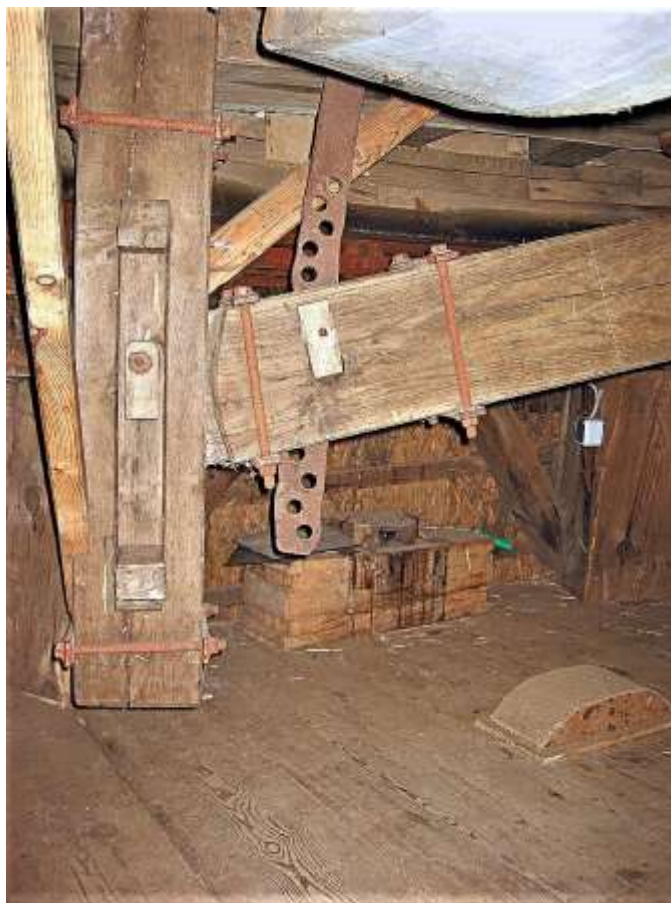
Épée du frein avec la bascule. Notez les différents œils destinés régler la longueur de l'épée. Photo K. Vanger.
