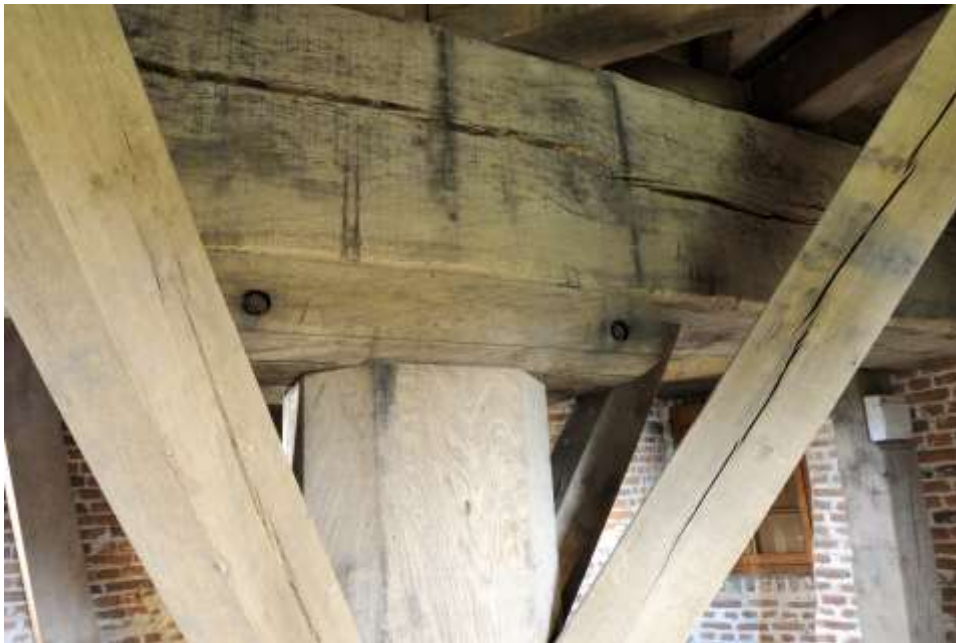
Moulin Vertain de Templeuve. Pivot surmonté du maître-sommier, avec quelques aisseliers. Photo de l'auteur.
