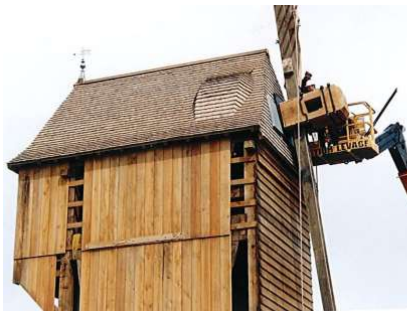
Moulin de Valmy (Marne) pendant sa récente restauration. Cambre pour le rouet dans la toiture. Photo J.B.
