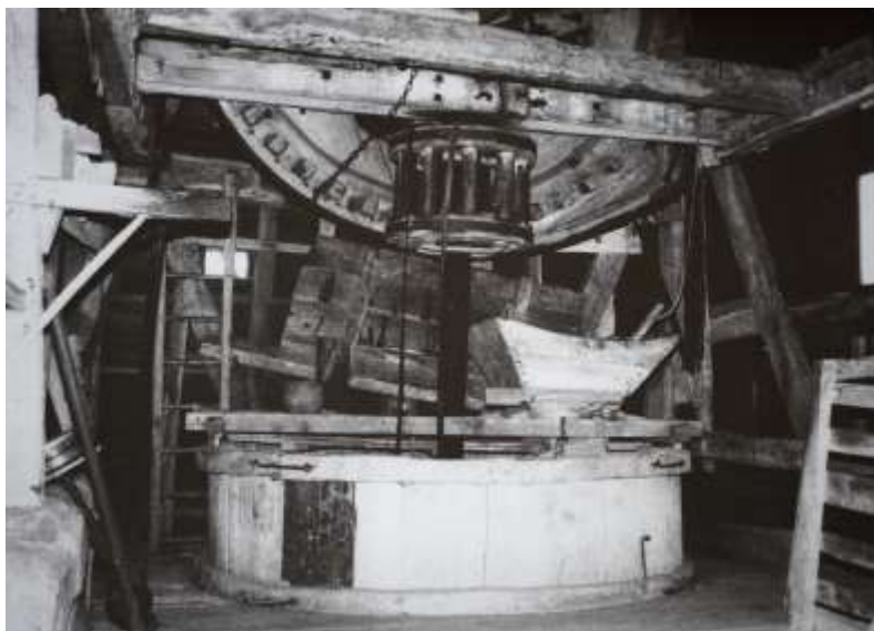
Trémions horizontaux au moulin de Saint-Maxent (Somme). Photo J.B. (1989).
