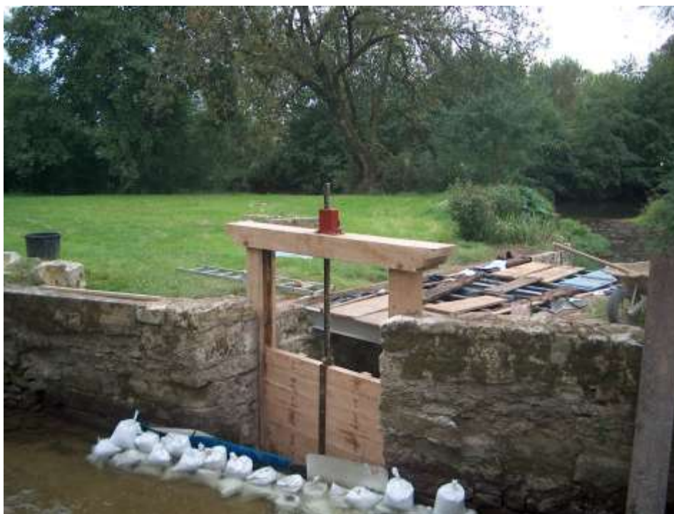
Aménagement d'une nouvelle ventelle au moulin de Gouny à Montignac (Dordogne)
