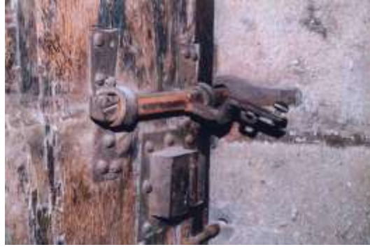
Verrou et serrure à bosse (13 e -14 e siècle) de la cathédrale de Rodez (Aveyron). Photo de Philippe de St Wandrille ( http://vimeu.free.fr/articles.php?lng=fr&pg=174 ).
