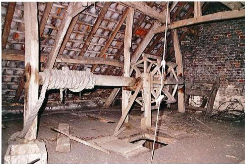
Moulin à eau de Haut-Loquin (Pas-de-Calais) (1999). Treuil aux meules avec son tambour à l'extrémité de l'arbre, sans le moulinet. Le câble des meules est enroulé sur l'arbre. Le treuil est aménagé sous les combles du bâtiment, au-dessus d'une trappe. Photo J.B.
