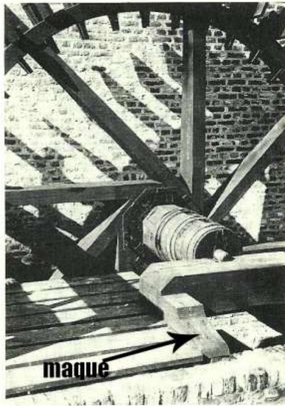
Maque qui empêche le recul du joug ou sommier du tourillon. Photo WLD, p. 96, ill. 73
