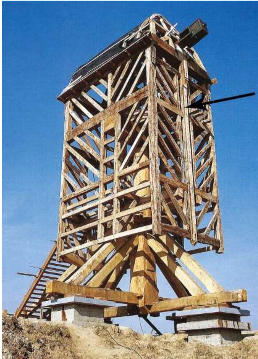
Charpente du moulin à farine de Villeneuve-d'Ascq (Nord) : grue. Photo J.B.
