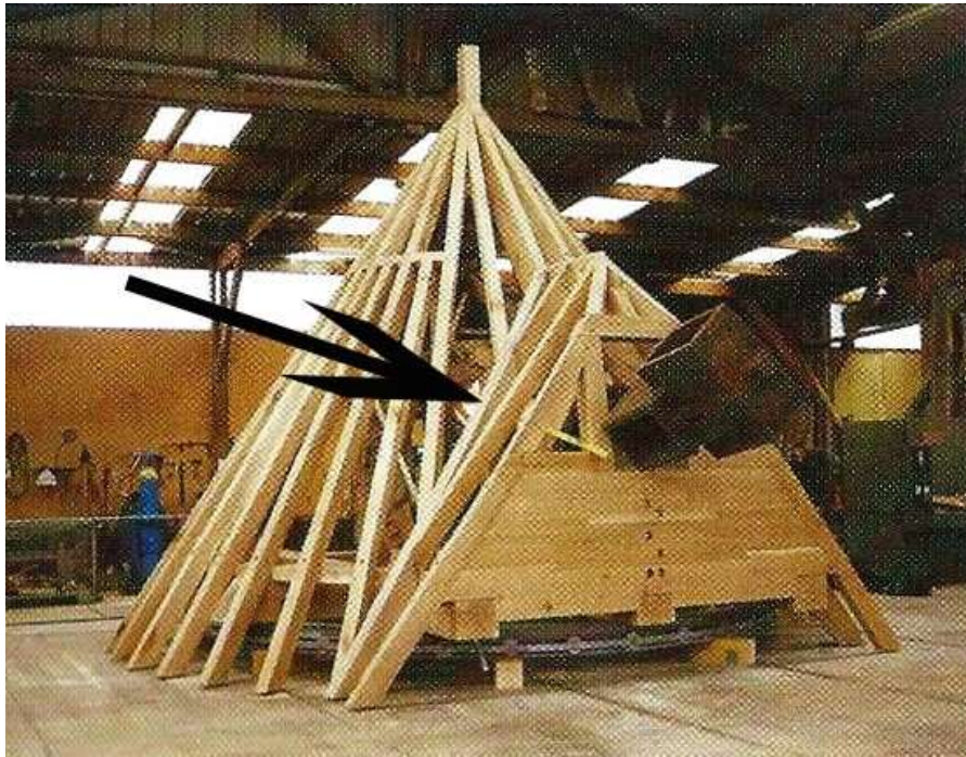
Noüe aux combles destinés au moulin de Montceau-Écharnant (Côte-d'Or). Photo J.B.
