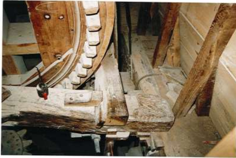
Vue plongeante dans le moulin de Moulbaix (Hainaut) : le bauchet du frein surmonte le palier du gros fer (sur lequel est posée une burette) et est retenu par un taquet ; il est parallèle à la haute-panne qu'on distingue plus à droite. Photo J.B.
