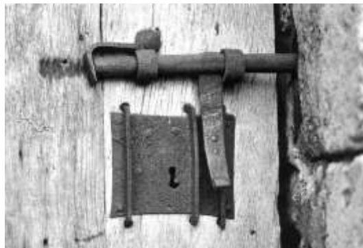
Verrou et serrure plate (14e-15e siècle) du chateau de Billy (Allier). Photo Philippe de St Wandrille ( http://vimeu.free.fr/articles.php?lng=fr&pg=174 ).
