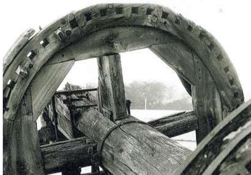
Ancien rouet de Templeuve (Nord) : les bras relient les quatre chateaux qu'on a complétés par quatre pièces triangulaires, les goussets ; on distingue bien le parement avec les lumières pour les alluchons. Photo J.B.
