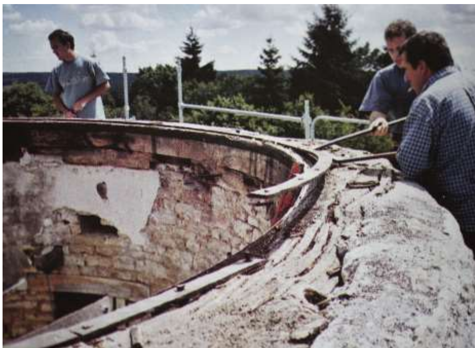
Ouvriers travaillant à la barre de fer plate du chemin de roulement pendant la restauration du moulin-tour de Montceau-Écharnant (Côte-d'Or). 2001. Photo J.B.
