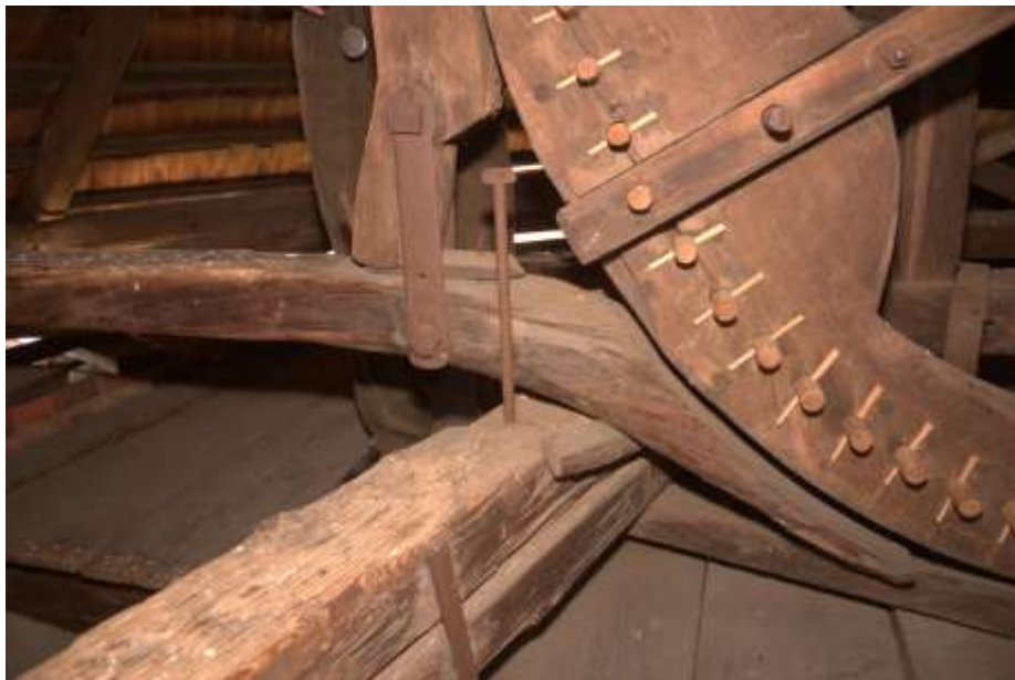
Détail d'un frein à sabot tchèque. Photo A. Koopal
