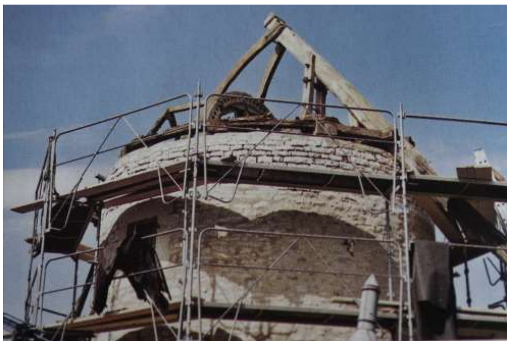
Boutreaux de la queue à l'intérieur de la calotte, visibles pendant la restauration du moulin-tour de Montceau-Écharnant (Côte-d'Or) 2001. Photo J.B.
