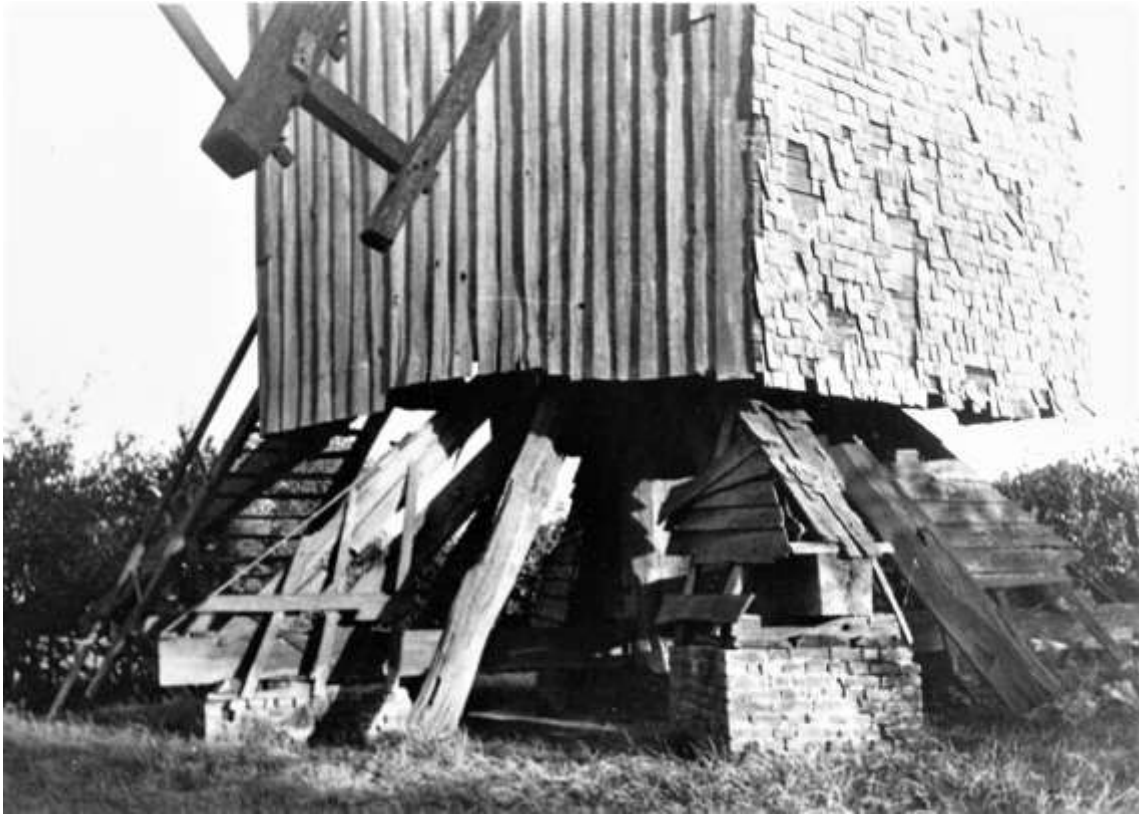
Manteaux au moulin de Serain (Aisne) (1953) : au lien de gauche la disparition du revêtement permet de distinguer l' armure du manteau. Faux-lien (→ faux loyen ). La paroi latérale de la cage est couverte de planches verticales chevauchantes, la paroi au vent de planches horizontales et de bardeaux. Photo H. A. Webster (1953)
