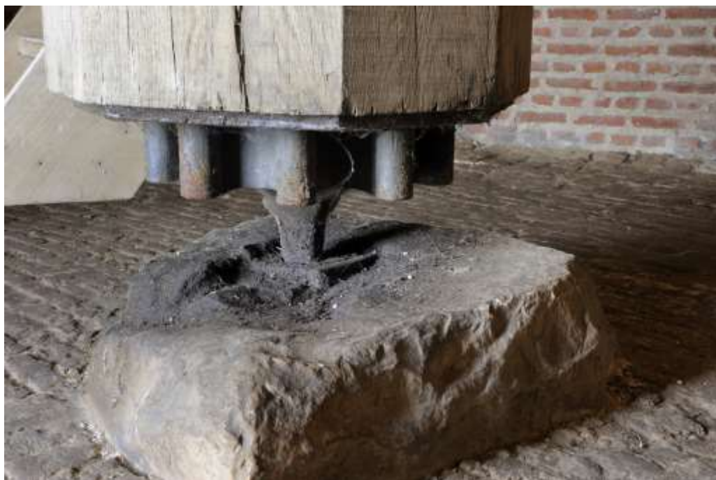
Moulin Vertain de Templeuve (Nord) : crapaudine du pivot tournant incorporé dans une grosse pierre. Photo de l'auteur.
