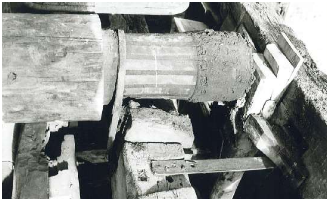
Collet de fer au-dessus du petit collet du moulin de Steenvoorde (Nord). Photo J.B. (1993)
