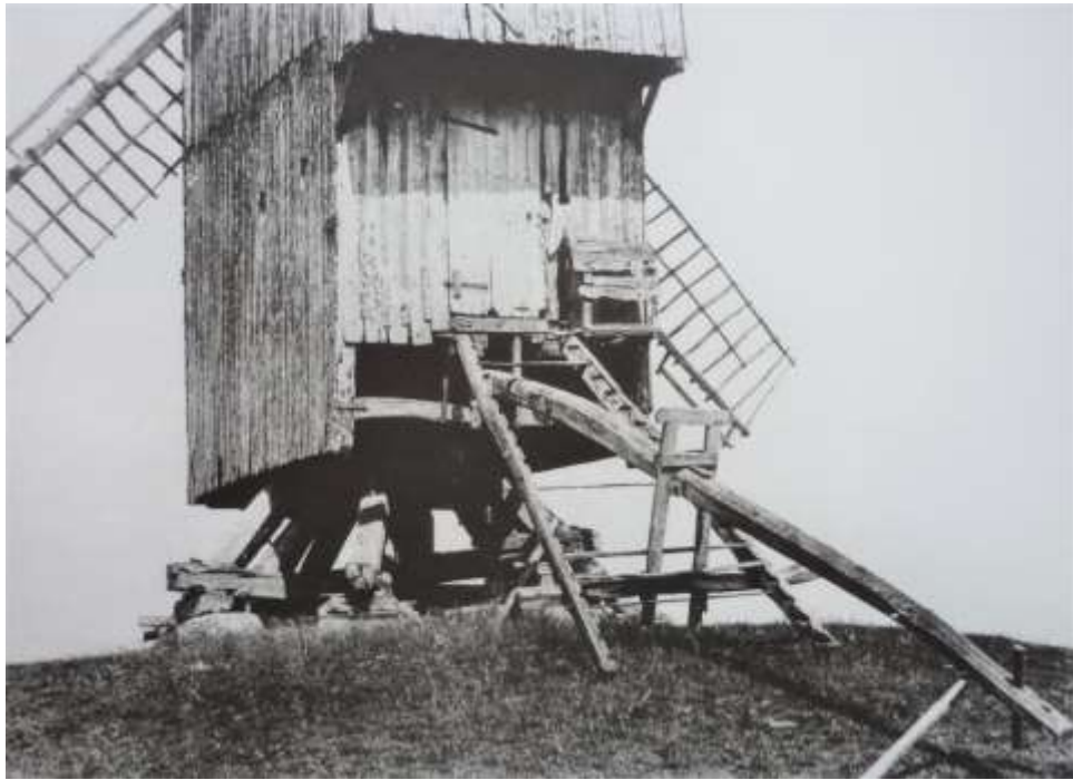
Ancien moulin de la Somme. Escalier suspendu à la queue au moyen d'un chevalet fixé sur une °traverse plus large que l'escalier. Collection Ph. Webster.
