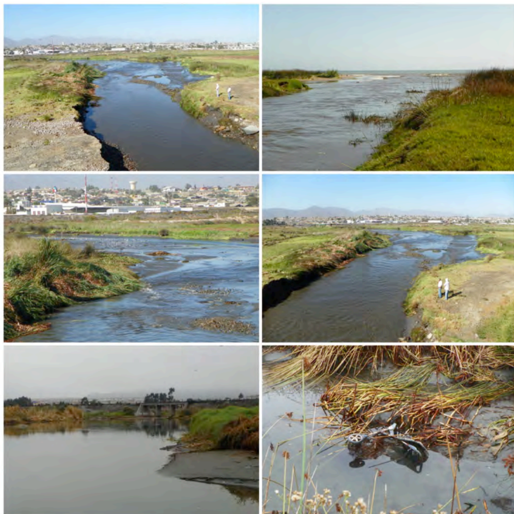
Figura 9.10: Ingreso de agua, daños del tsunami de campo lejano proveniente de Japón y que arribó a nuestras costas el 12 de marzo de 2011 en el humedal Estero Culebrón, Coquimbo.
