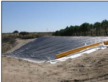
Impermeabilización de Diques
