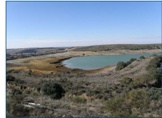
Dique de estériles
