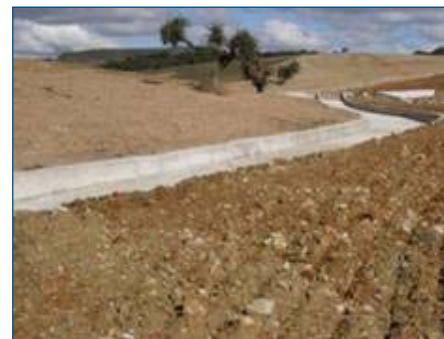
Construcción de drenajes y canalizaciones: 10 km
