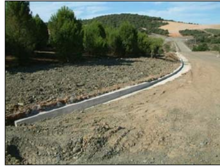
Canalizaciones de drenaje
