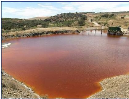
Balsa de aguas ácidas
