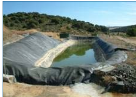
Diques y Balsas de aguas: 1Mm 3
