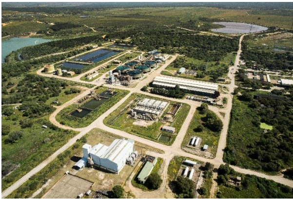
Instalaciones industriales (parcela de proceso)
