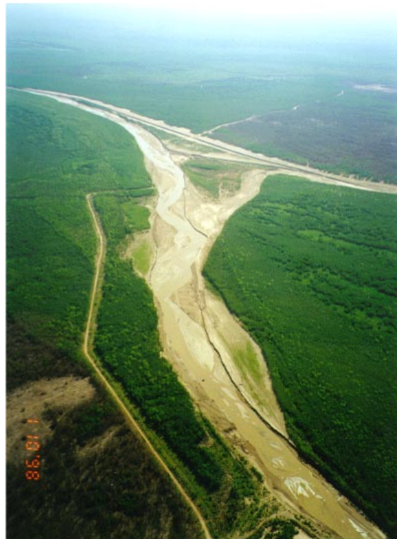
Figura 3.- Vista general hacia aguas arriba (NO) de la zona de taponamiento, y del Canal Farías en primer plano (Octubre 1998).
