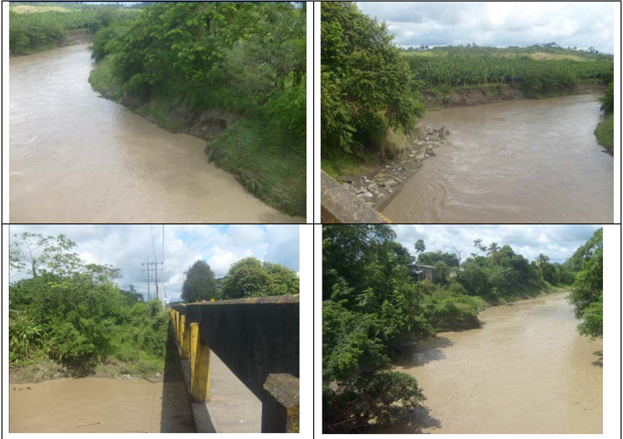
Foto 31 Sector Puente sobre el Río Carepa
