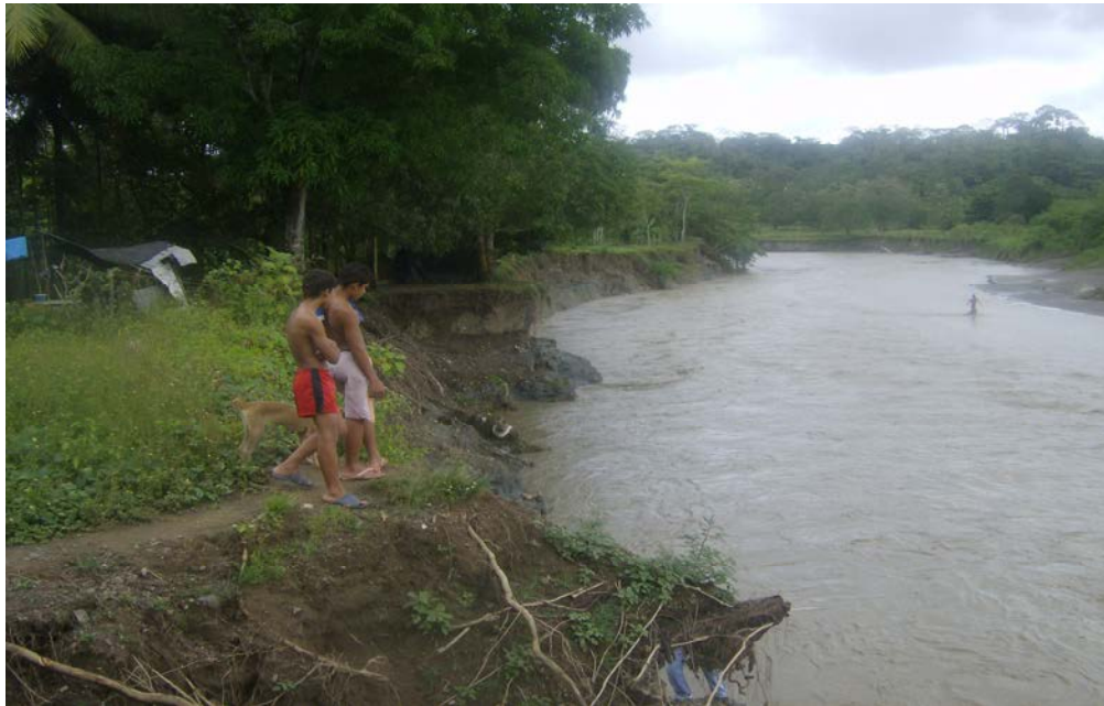
Foto No 6 Vista general de los procesos de erosión lateral en suelos arenosos. Sector barrios Gaitán y Jardín
