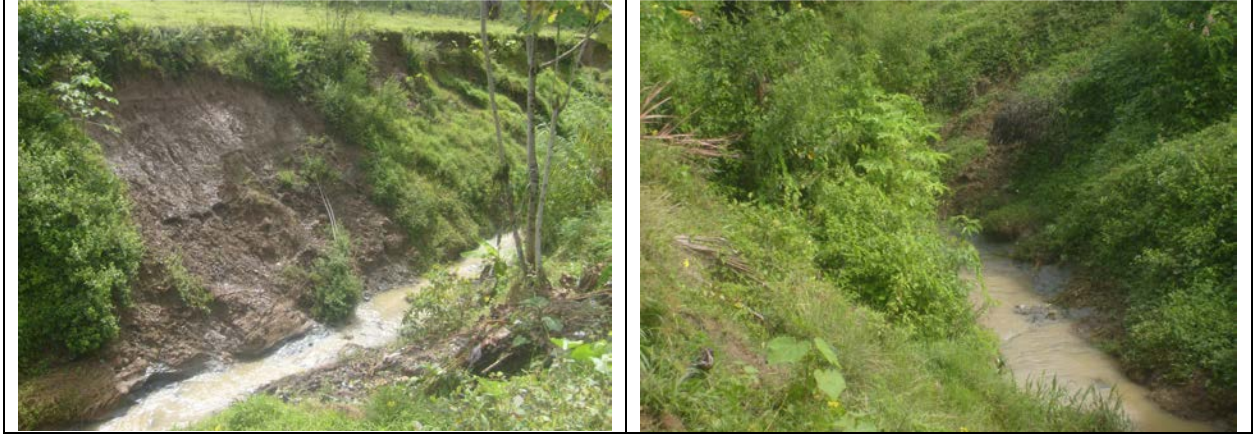
Foto 26 Caño Afluente al Carepa
