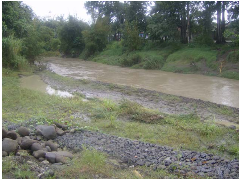
Foto No 14 Obras de protección lateral Barrio El Darién.
