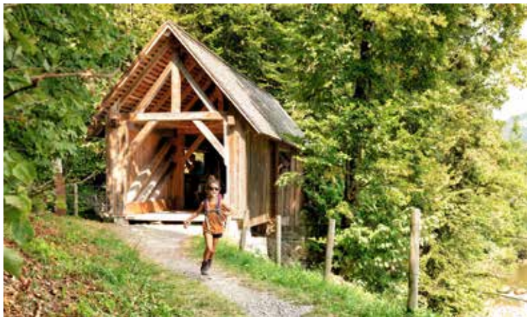
Kommabrücke in Hittisau
