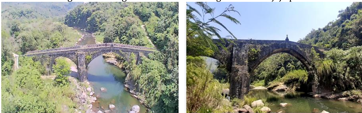
Figura 11 Fotografías del Puente Antiguo del Río Ajajalpan
