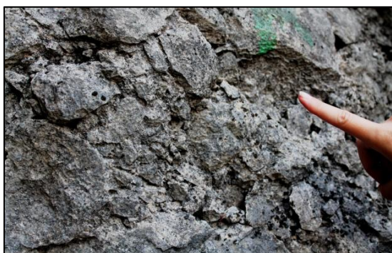
Figura D87. Caliza brechada que constituye la roca del Morro.
