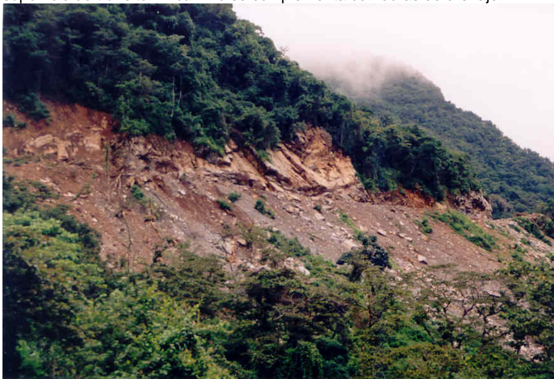
Uno de los derrumbes, el mayor, en la brecha que se habilitará, km 5.+200.
