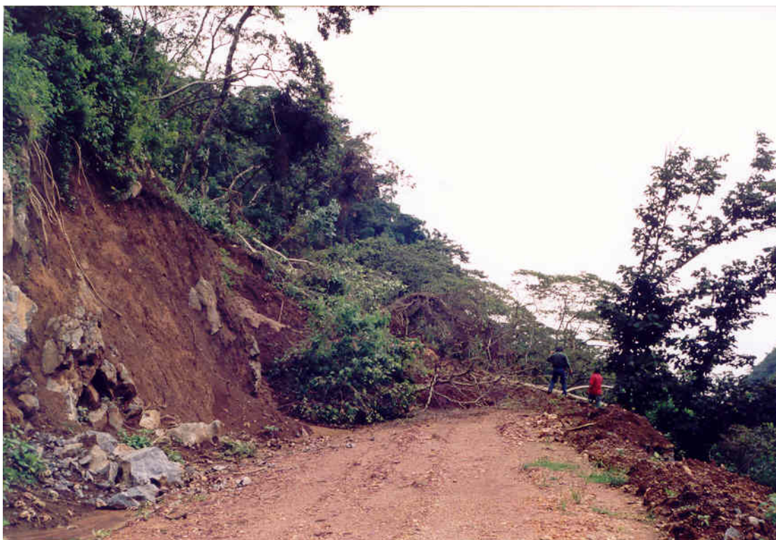
Aspecto de la brecha existente y derrumbes que lo afectaron
