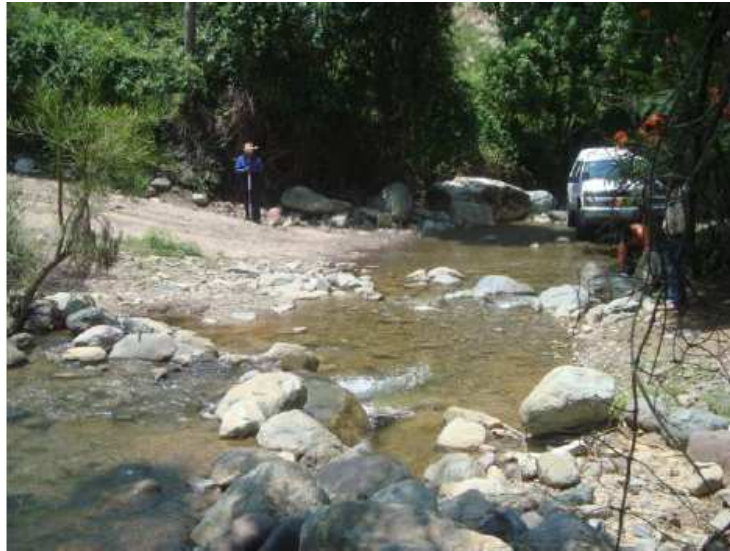
Figura II. Rio El Limón sobre el cual se proyecta el puente a construir
