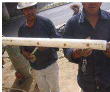
Tubo de PVC habilitado para inyección.
