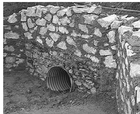
En esta imagen se muestra la construcción típica de alcantarillas de mampostería de piedra.
