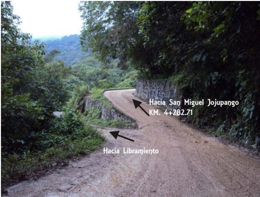
Fotografía 2. Se muestra la salida del camino que viene de la localidad de San Miguel Jojupango Uniéndose al libramiento Km. 4+282.71. Con coordenadas UTM 628554.93E, 223239.93N, 899msnm.
