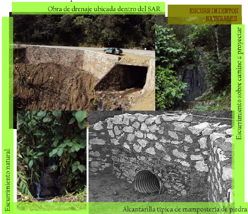
Imagen 3.- Escorrentamientos naturales y acciones a implementar con la construcción de obras de drenaje menor.
