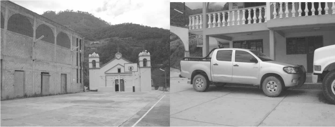
INFRAESTRUCTURA Y VEHÍCULOS
