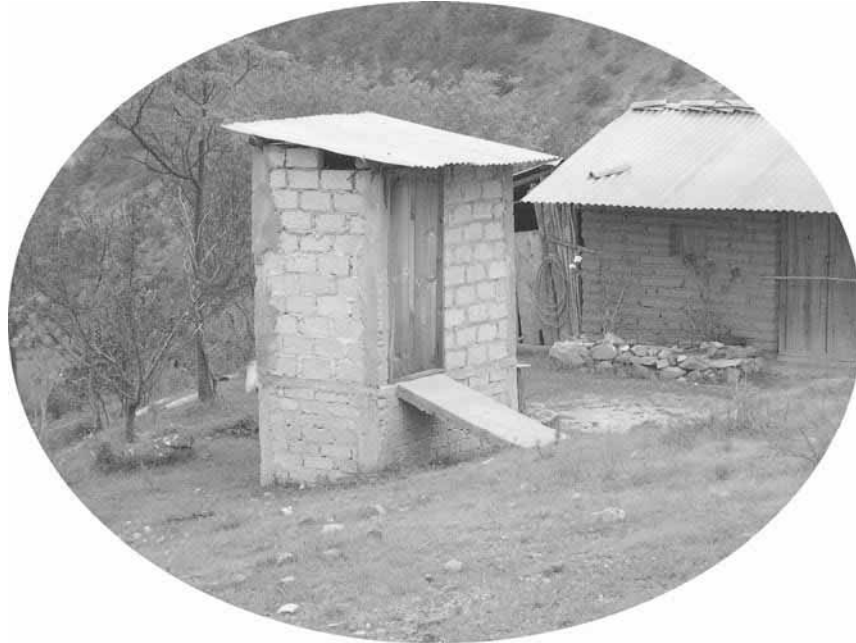
FIGURA 14. INSTALACIONES DE LA CLÍNICA IMSS-OPORTUNIDADES Y LETRINAS CONSTRUIDAS EN LOS HOGARES
