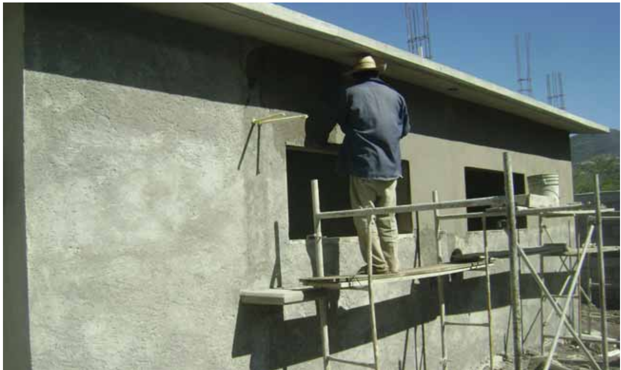
Acondicionamiento de nuevos espacios en la Unidad de Salud en la Cabecera Municipal
