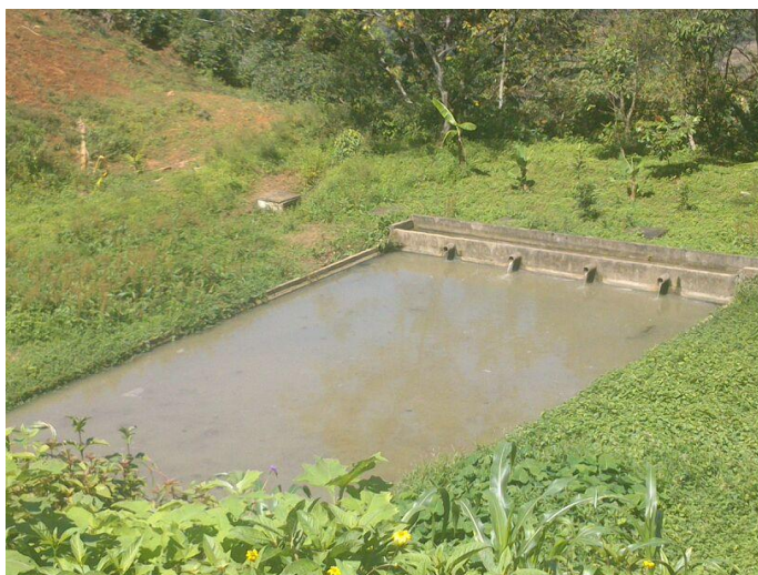
Figura 17. Planta de tratamiento de aguas residuales actual.
