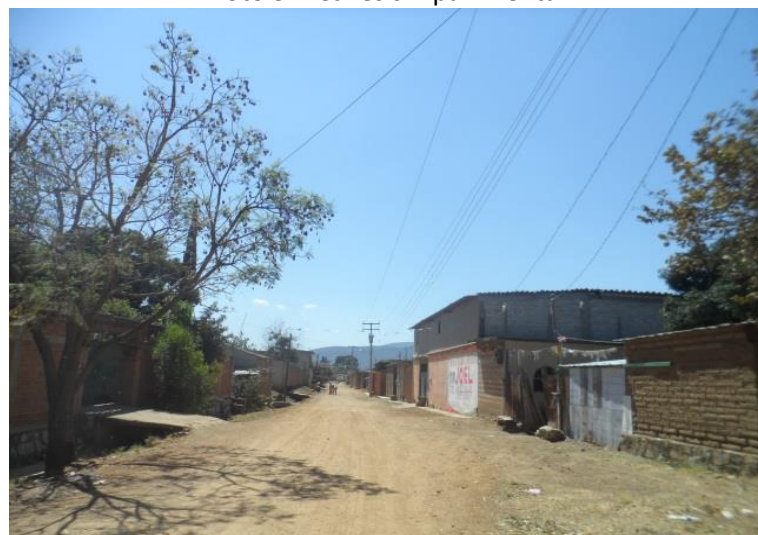
Foto 54. Calles sin pavimentar
