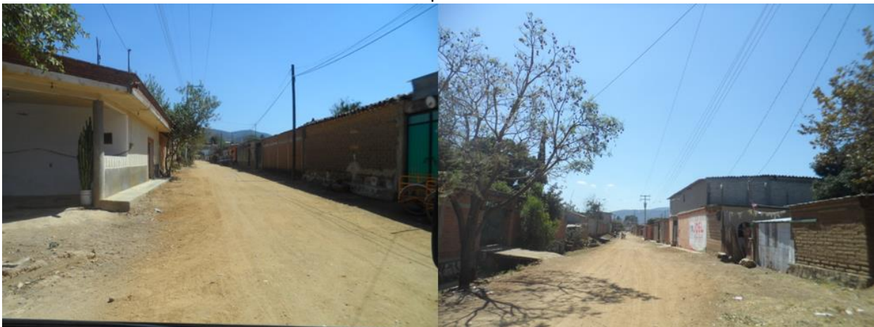
Foto 39. Calles sin pavimentación.
