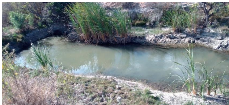
Fig. 34 Bordo para retención de agua de lluvia.
