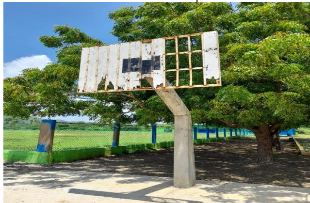
Foto 10. Tablero de baloncesto en pésimas condiciones
