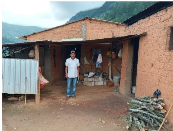
Muchas viviendas del municipio tienen piso de tierra, paredes de adobe y techos de lámina
