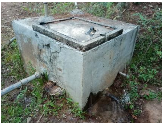
A la izquierda, tanque deteriorado en el sistema de agua potable de la Agencia municipal Las Delicias y a la izquierda tanque de reciente construcción en la misma localidad.
