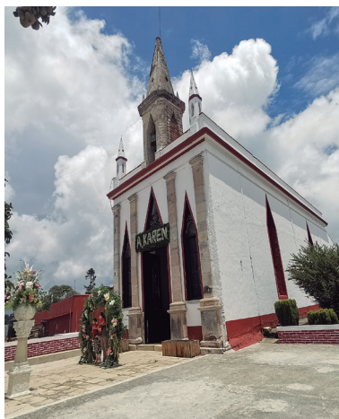
Capilla de la Virgen de Guadalupe, construida entre 1909 y 1910, de estilo neogótico.
