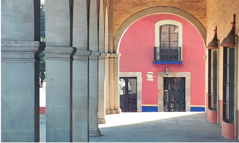
Casa del Portal, una de las casonas más importantes del municipio por su antigüedad e historia. Conserva una hermosa tienda de finales del siglo XIX.
