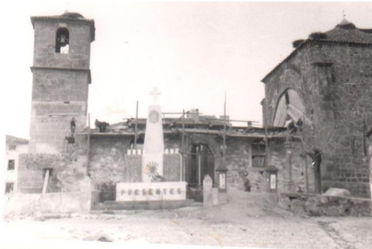
Reconstrucción de la Iglesia de Parrillas (1962)
