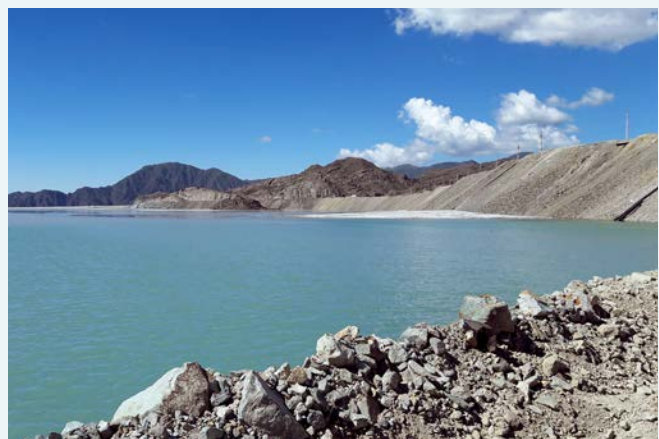
Más del 70% del agua que se utiliza en el proceso se recicla a través de un sistema de retrobombeo.
