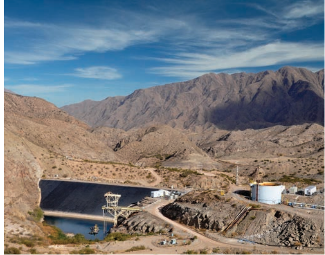
Laguna colectora de agua recuperada.
