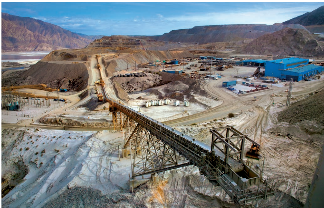
Vista general del circuito de alimentación de la planta de molienda.
