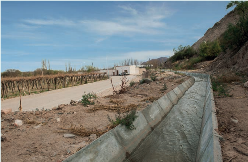
Los programas de desarrollo productivo de cultivos locales se complementan con obras de infraestructura para mejorar el acceso al agua mediante canales de riego.
