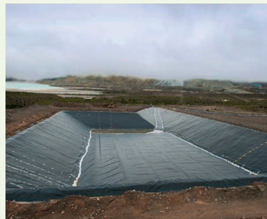
Vertedero controlado de residuos sólidos urbanos.
