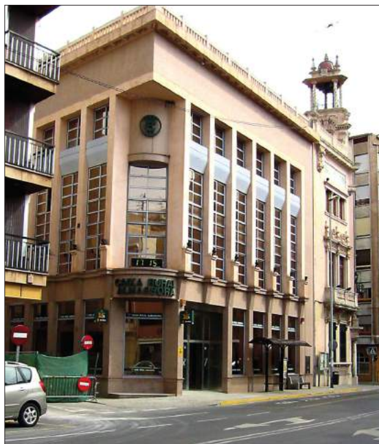
Estado reformado. Modificación acceso.
