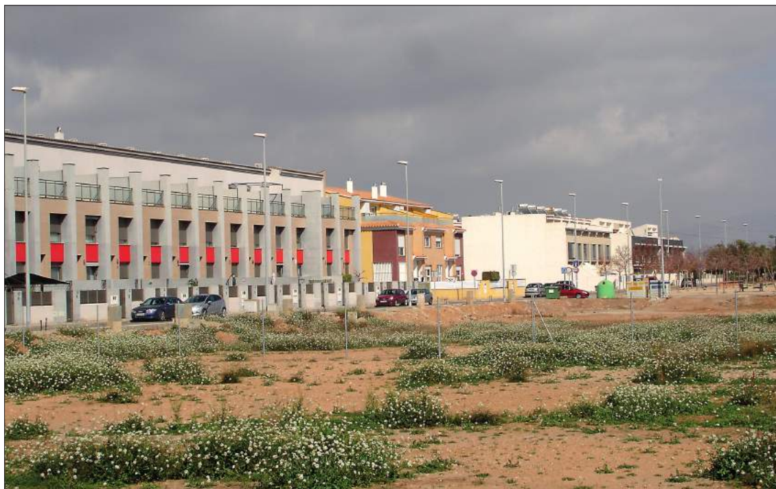
Figura 25. Expansión urbanística paralizada. Fuente: R. Pons y P. García.
