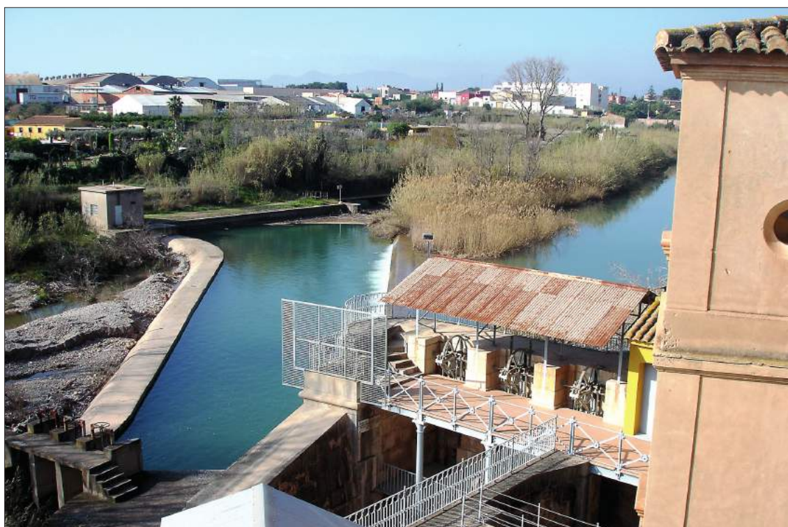
Figura 9. Azud de Castellón y Almassora, 1895.
