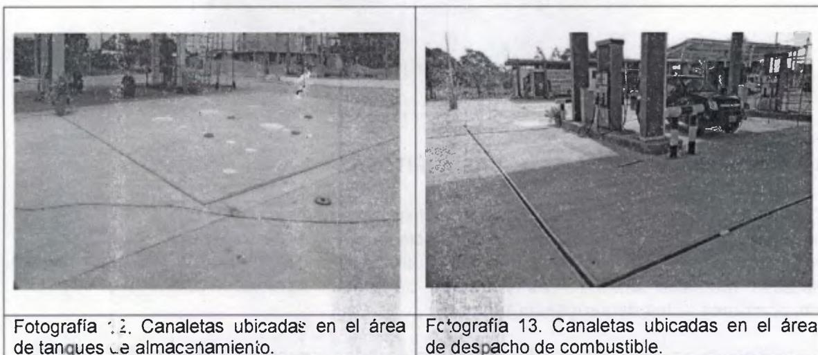
Fotografía 12. Canaletas ubicadas en el área de tanques de almacenamiento.
