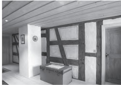
Links: Küche 0.05 nach der Restaurierung mit neu eingebautem Tonplattenboden, Deckentäfer und Holzherd. Zustand 2002.
