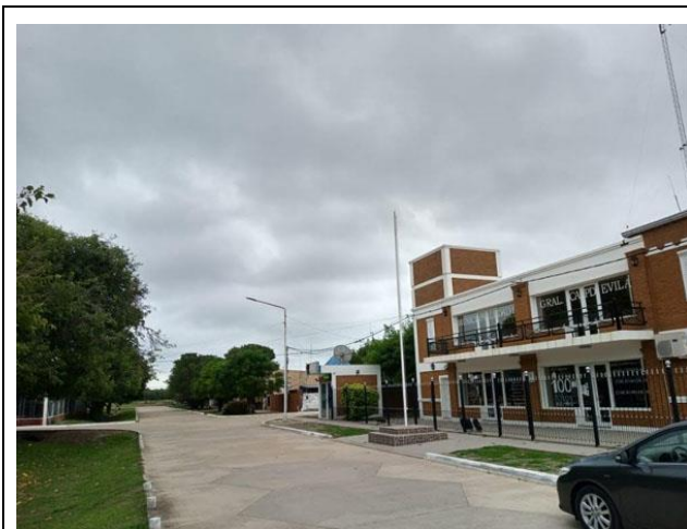
Figura 9: Edificio municipal de Gral. Capdevilla
