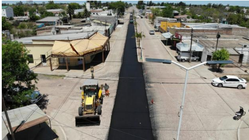
Figura 79: Trabajos de pavimentación en la Avenida Mariano Moreno en Gral. Pinedo
