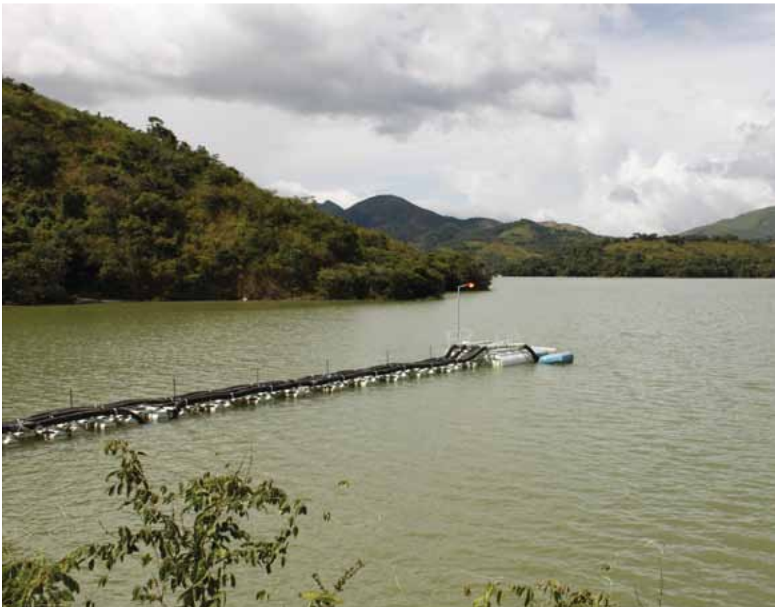
El agua de los torrentes son preciosas fuentes de alimentación de embalses construidos en el Parque Nacional Guatopo.
