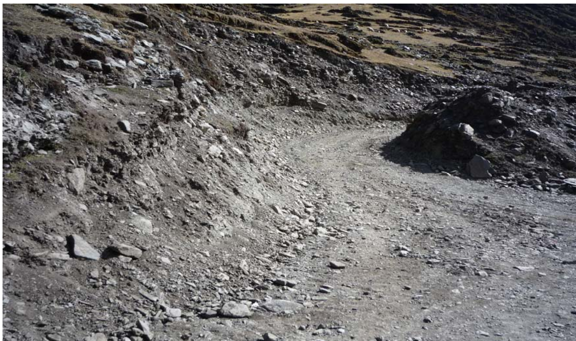
Se aprecia las malas condiciones de transitabilidad del camino vecinal del distrito de Cuyocuyo
