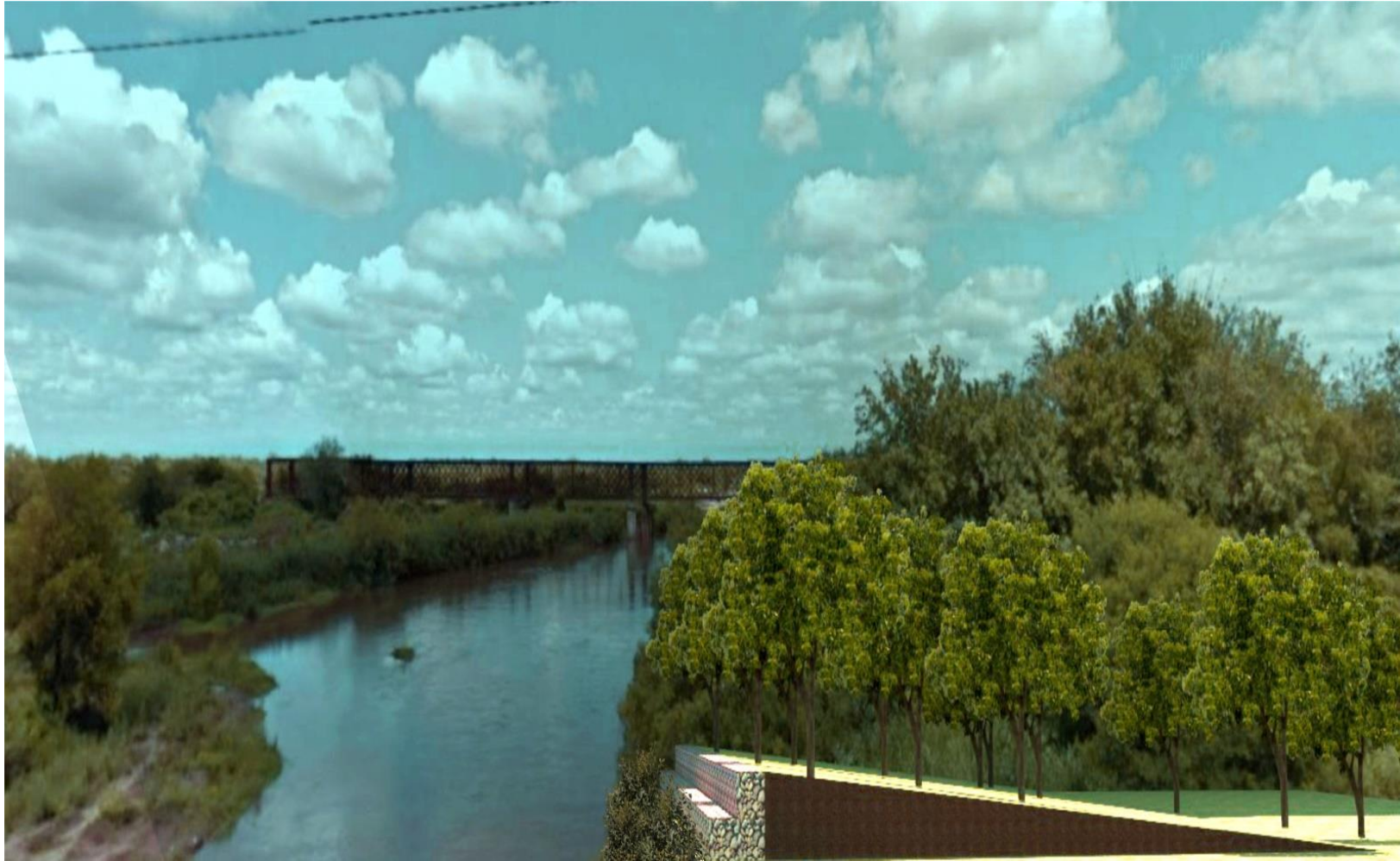
Sector de gaviones con arbolado en laderas
