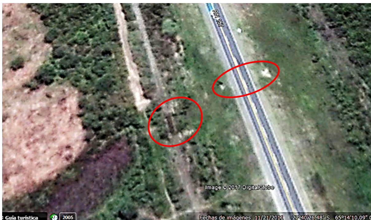
IMÁGEN 23 Vista del puente en vía Férrea paralela a RNN° 157 hacia el sur del puente del rio Marapa
