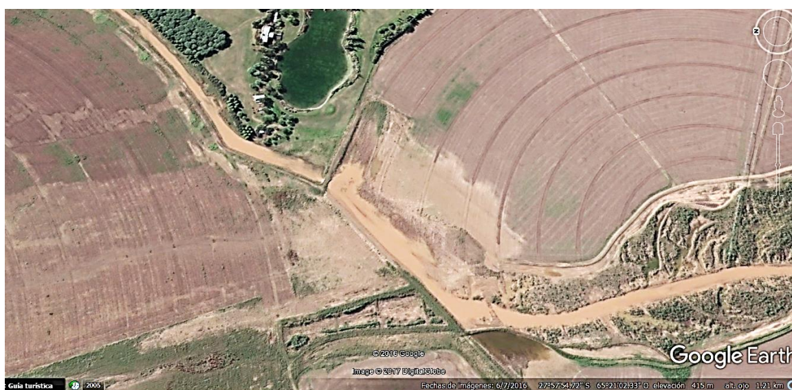
IMÁGENES 10 y 11 Canalizaciones concentrando el flujo de agua
